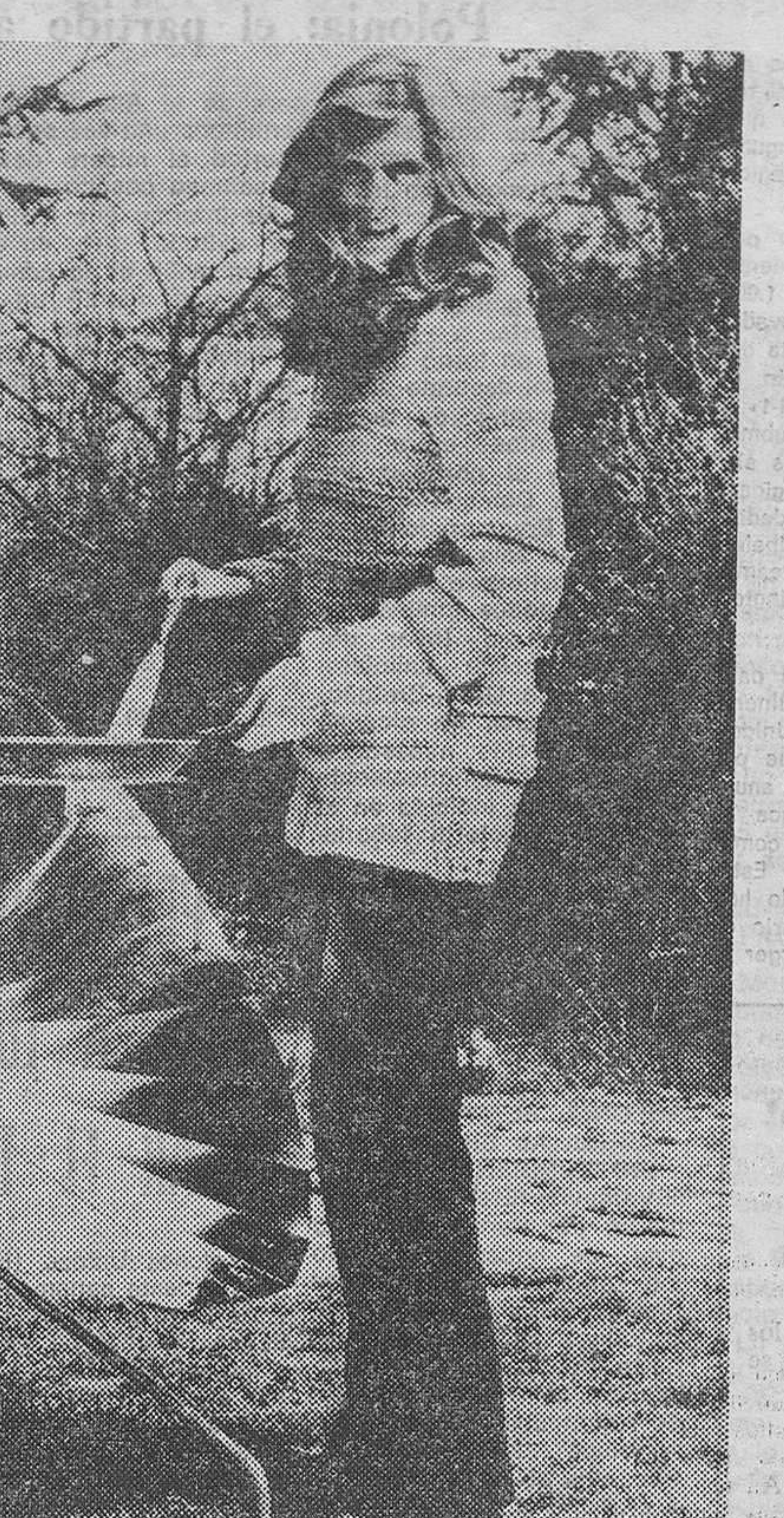
Esta «cocina solar» en forma de paraguas se convierte en un reflector parabólico en el que se concentran los rayos solares, generándose así la energía suficiente para preparar toda una comida.
