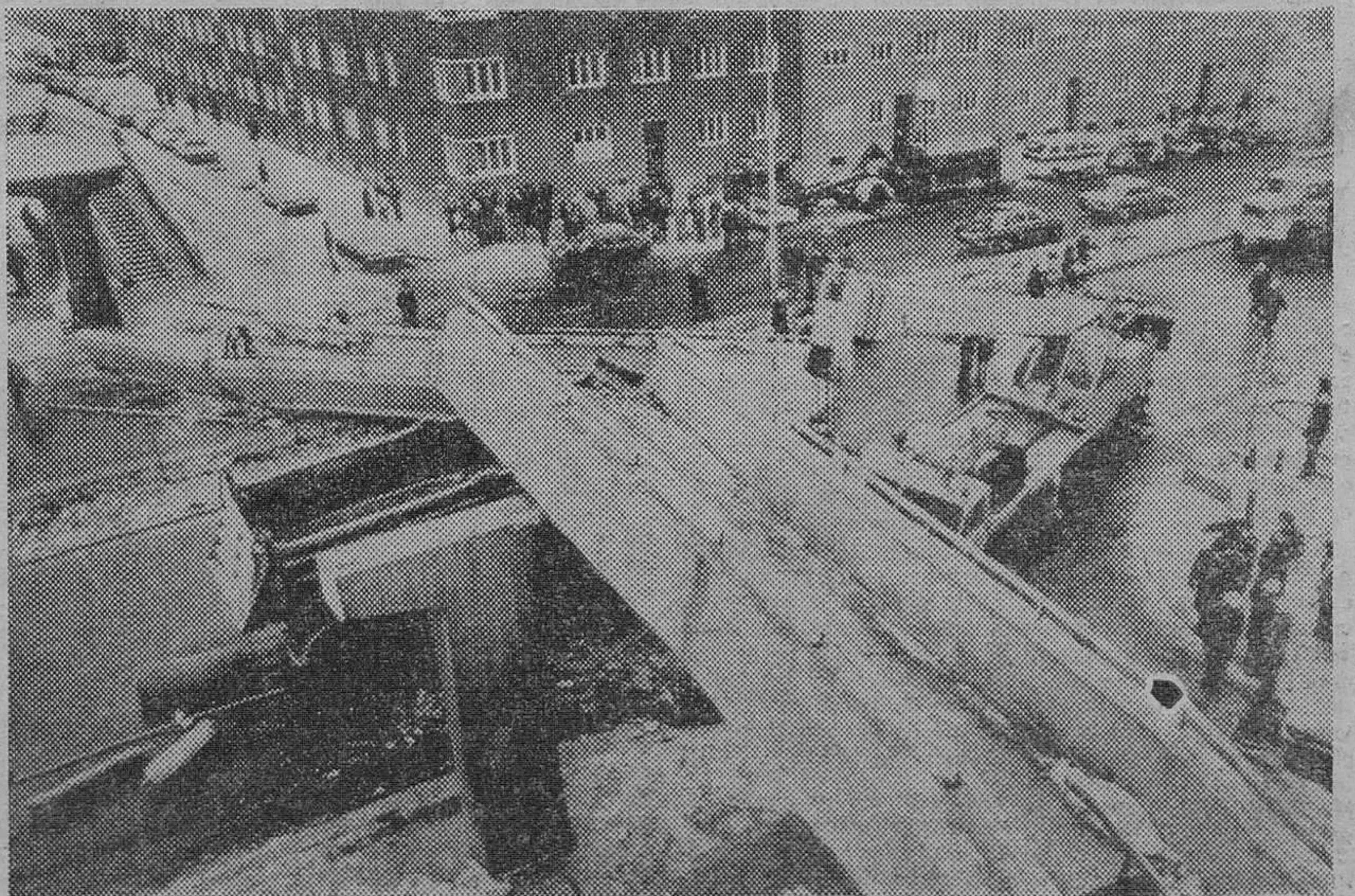
Munich (Alemania Federal). — Estado en que quedó el paso elevado de peatones de la calle münichesa de Bogenhausen que se derrumbó, después de que un camión chocara con el citado puente. Las tres personas que viajaban en el camión resultaron gravemente heridas. Afortunadamente no pasaba nadie por el paso elevado en el momento del accidente. — (Telefoto EFE-UPI).
