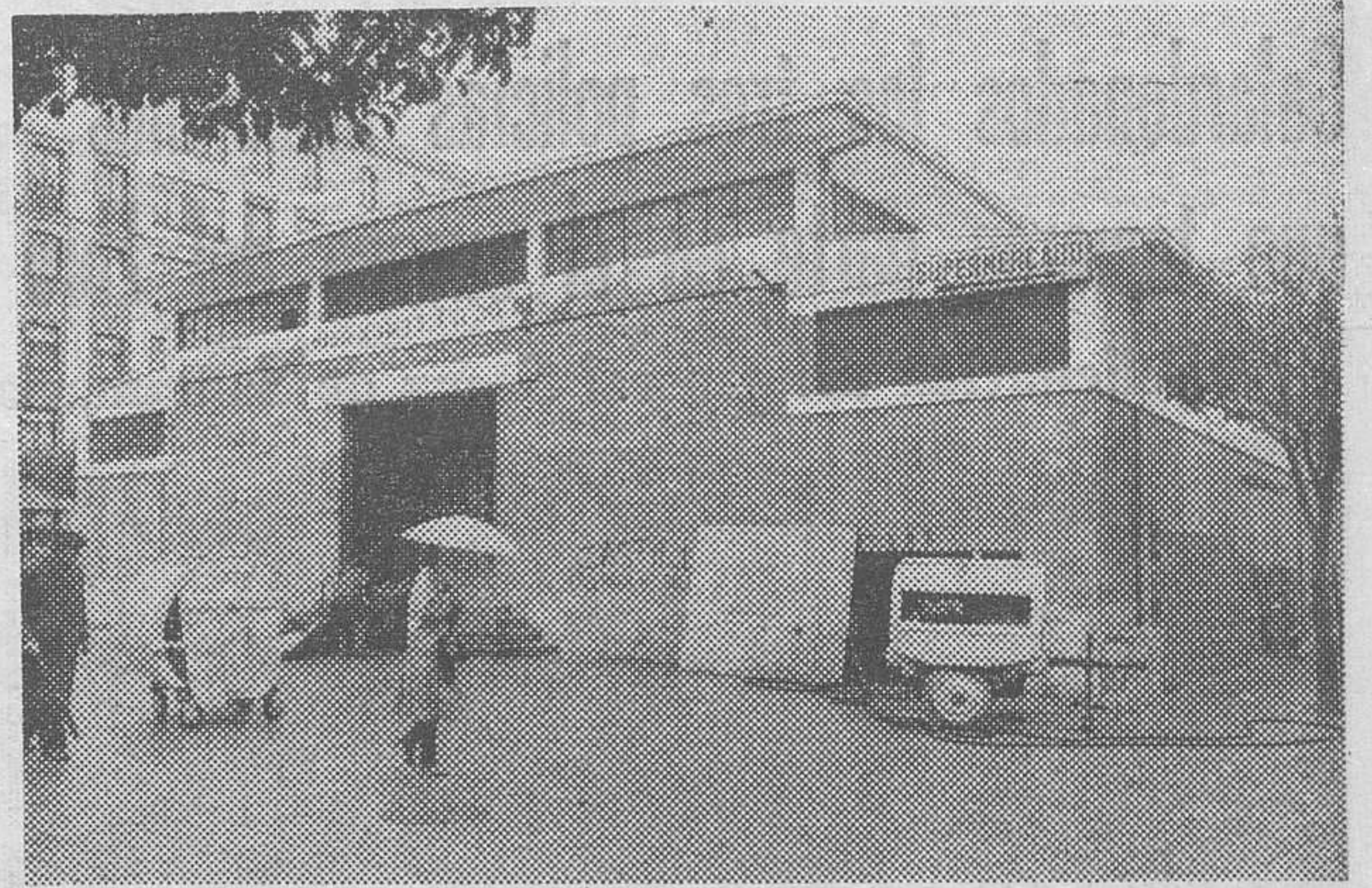
Este es el mercado de Abastos de la Zona Sur de nuestra capital, que hoy, martes, quedará cerrado por espacio de tres semanas para llevar a cabo en su interior importantes obras de mejora. — (Foto FEDE)
