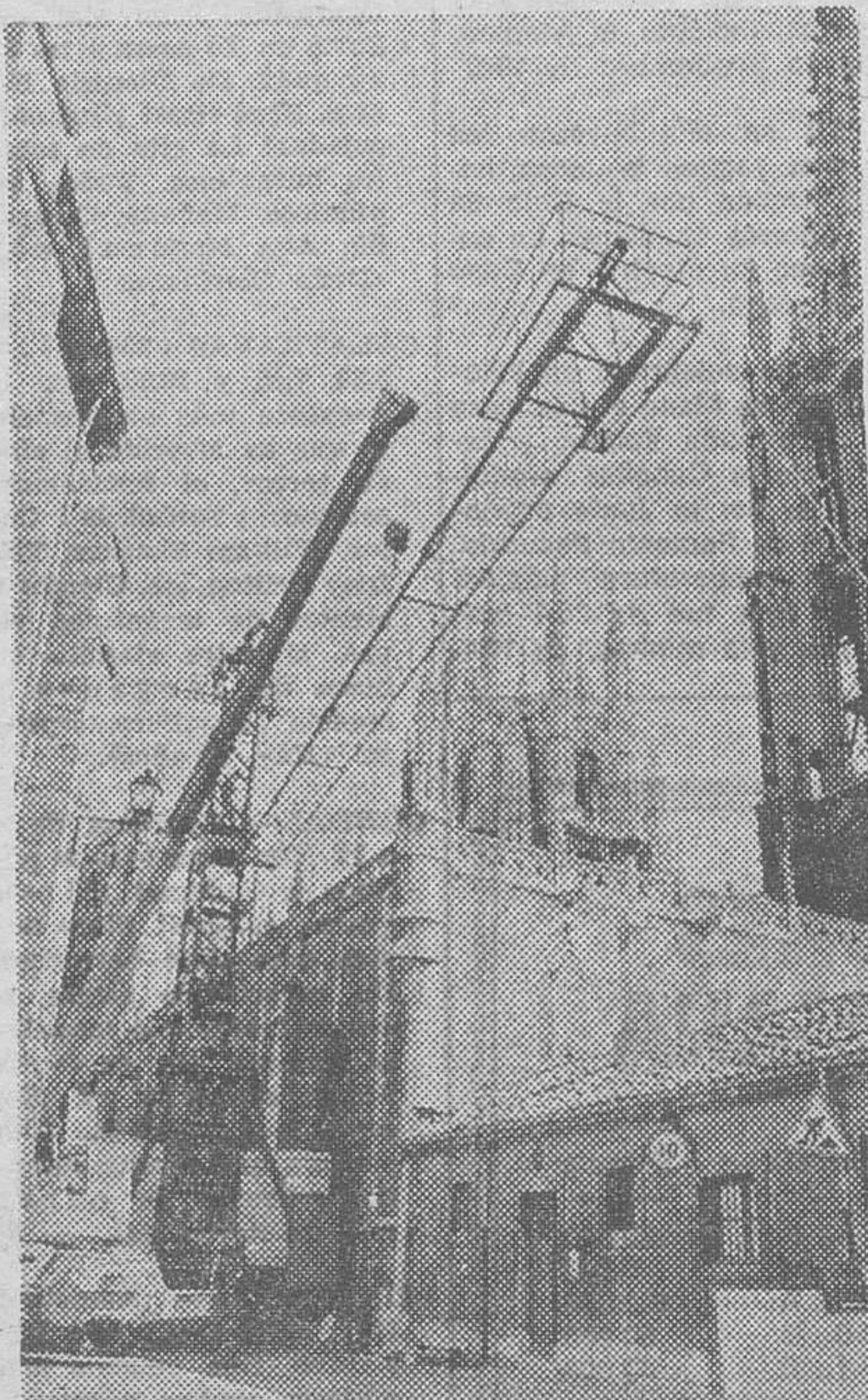
Esta es una de las grúas que se ha instalado para las obras de restauración de la Catedral en su segunda fase. La mayor utilizada en Burgos, hasta ahora, se colocará dentro de unos meses en la Plaza de Santa María. — (Foto FEDE).
