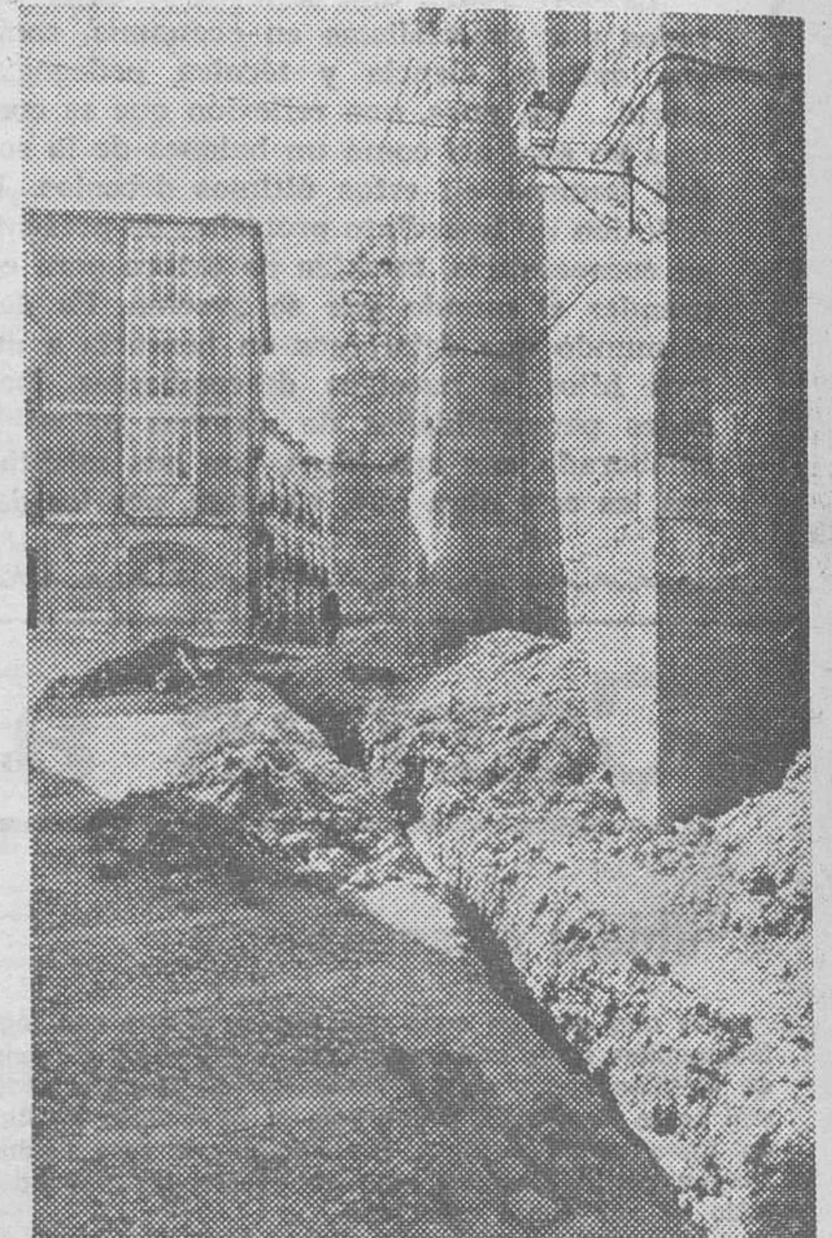
Comenzaron las obras de pavimentación de la calle de Santa Agueda, una vieja rúa burgalesa que tendrá el tratamiento adecuado a su carácter histórico-artístico. — (Foto FEDE)
