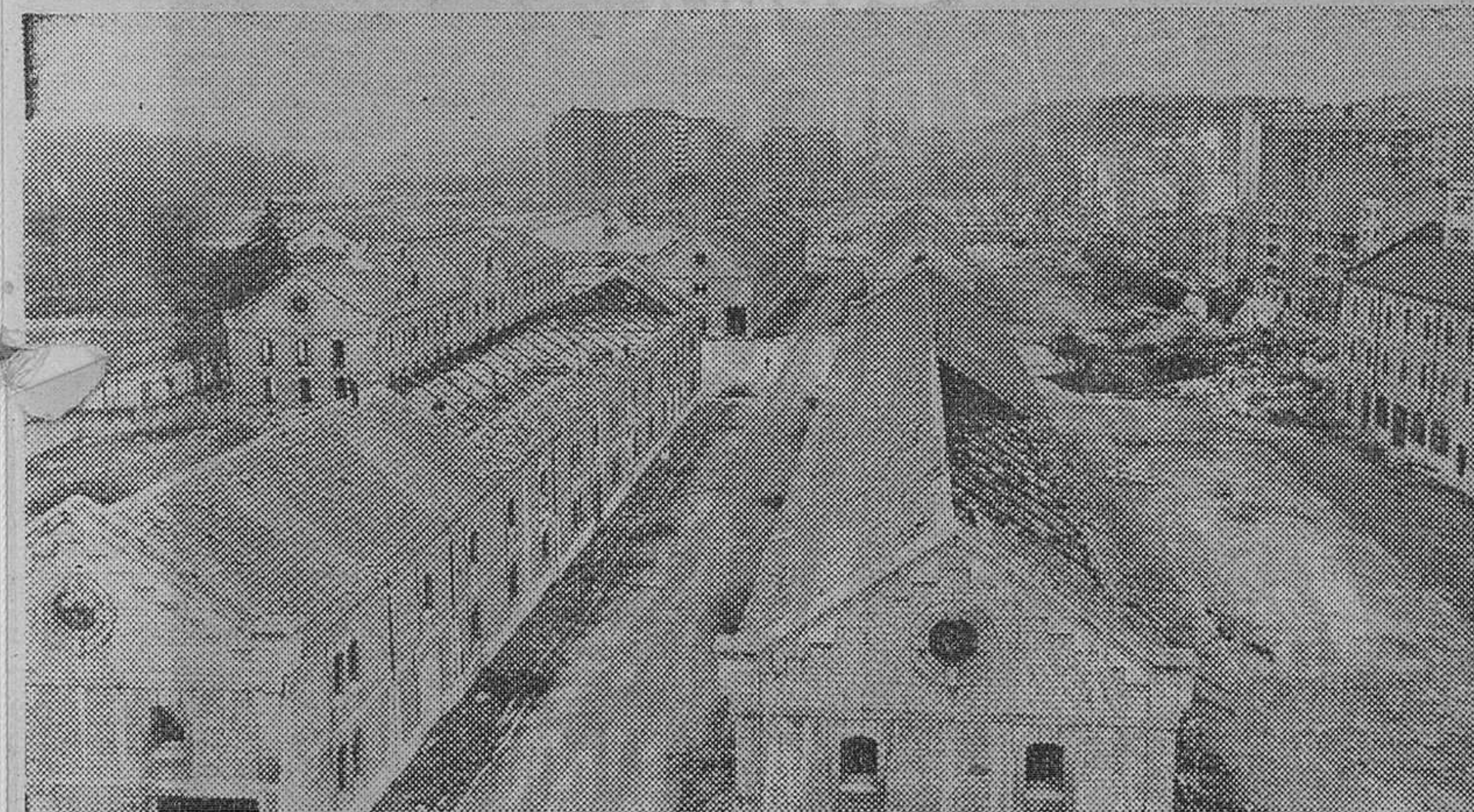
El derribo de los cuarteles de Infantería y Artillería cierra un capítulo de la historia local de principios de siglo para dar paso a otro capítulo abierto a esperanzados horizontes del moderno urbanismo. — (Foto FEDE).
