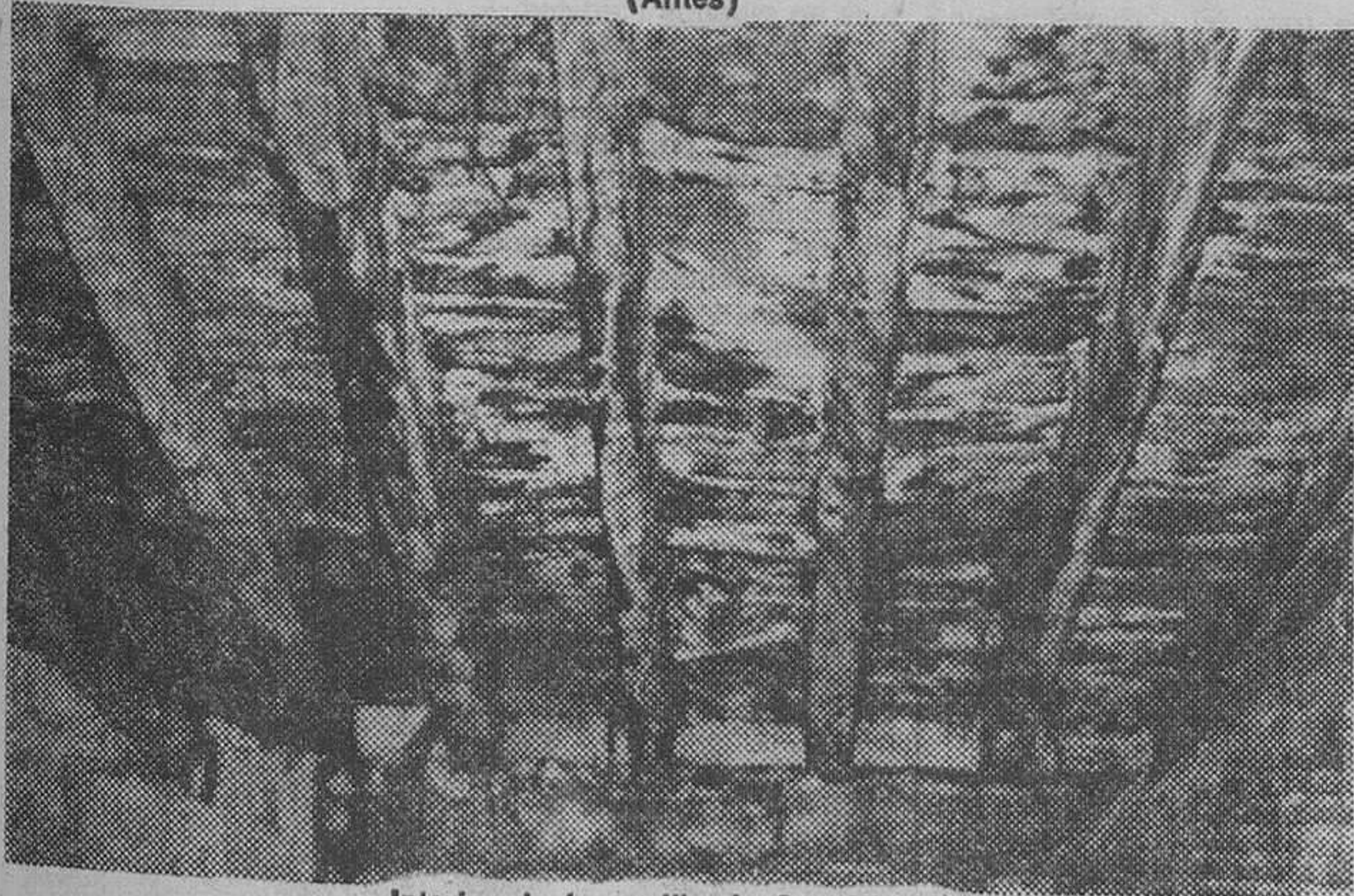
Interior de la capilla de San Nicolás (Antes)
