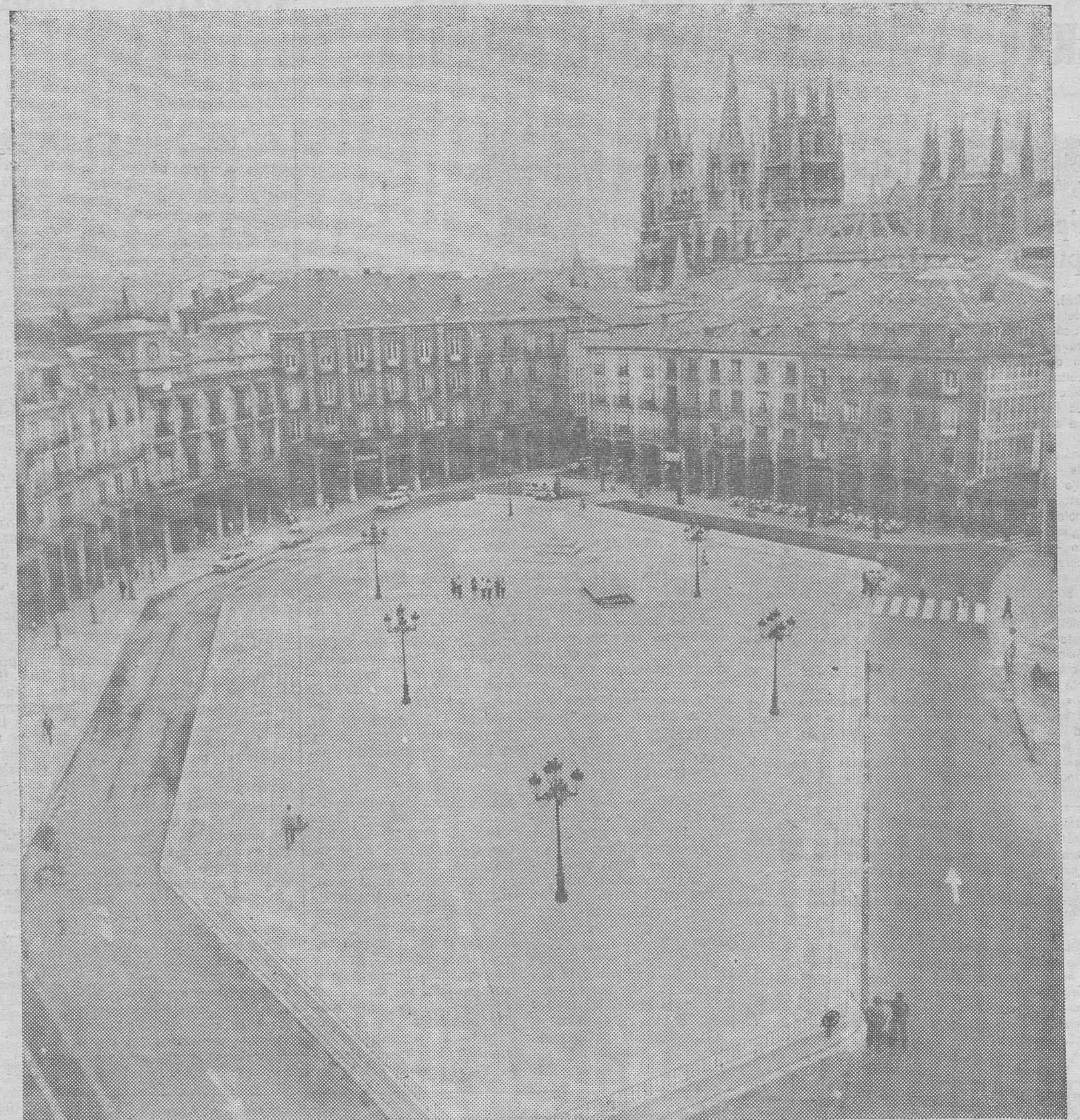
Así ha quedado nuestra Plaza Mayor, después de cinco años largos de obras, desde que comenzó a construirse el aparcamiento subterráneo. La foto es bonita, pero la falta arbolado.
