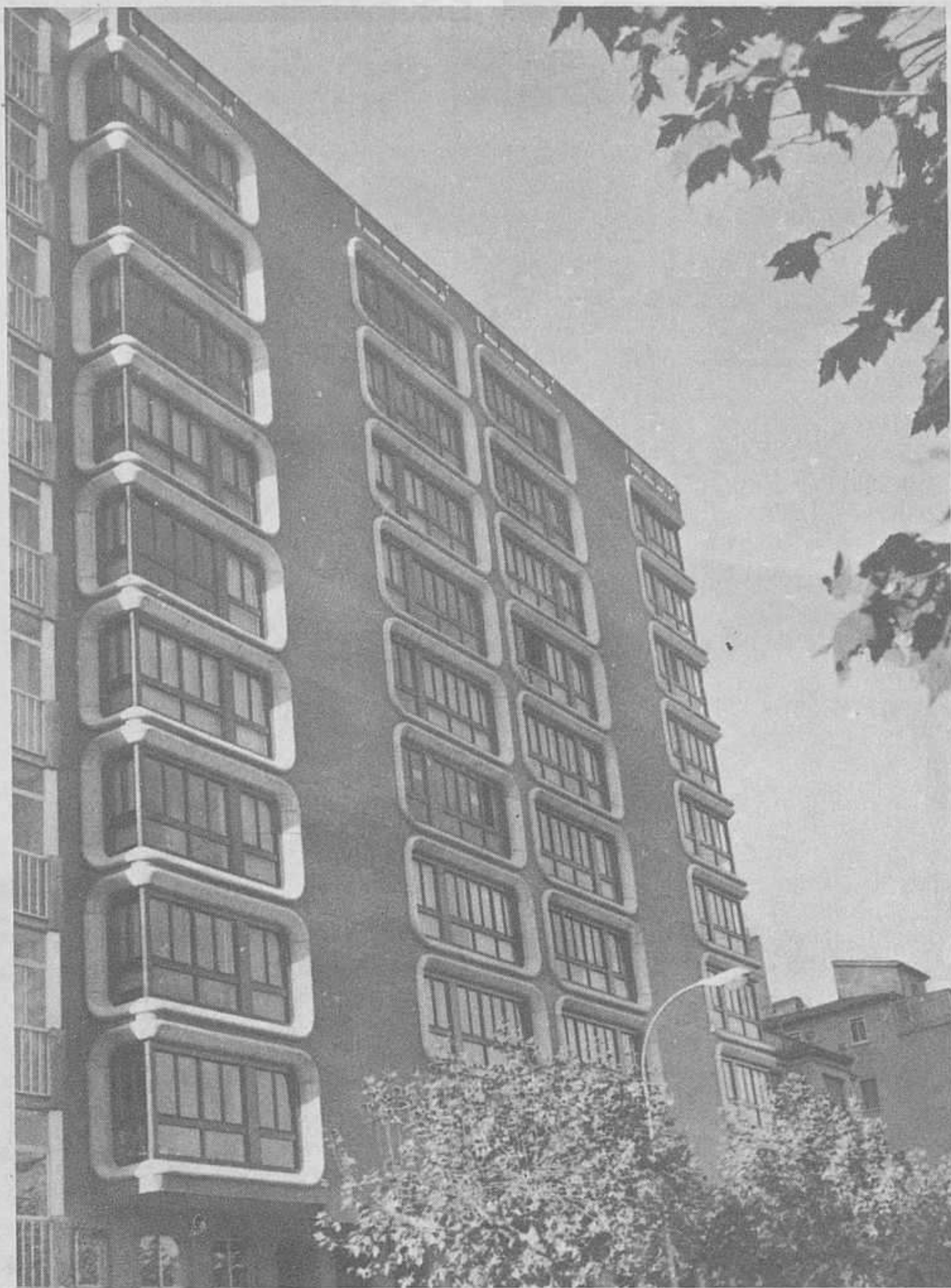
EDIFICIO CALLE VITORIA, 75
