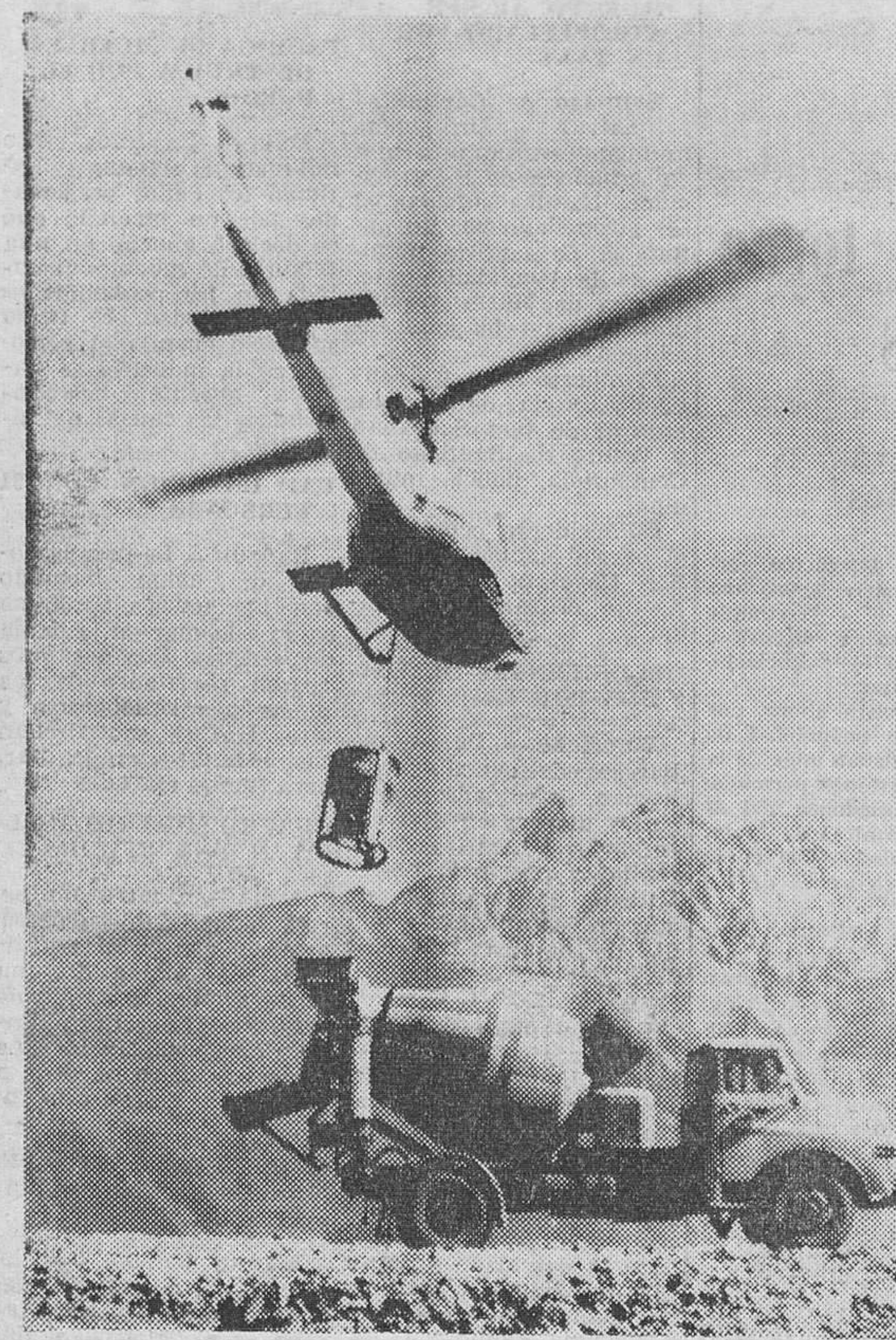
Oberstdorfe (Alemania). — Ante lo inaccesible del terreno a los vehículos, un helicóptero es utilizado para el transporte de materiales utilizados en la construcción de una telecabina en la cumbre de Fellhorn, cerca de esta localidad. — (Telefoto CIFRA GRAFICA)
