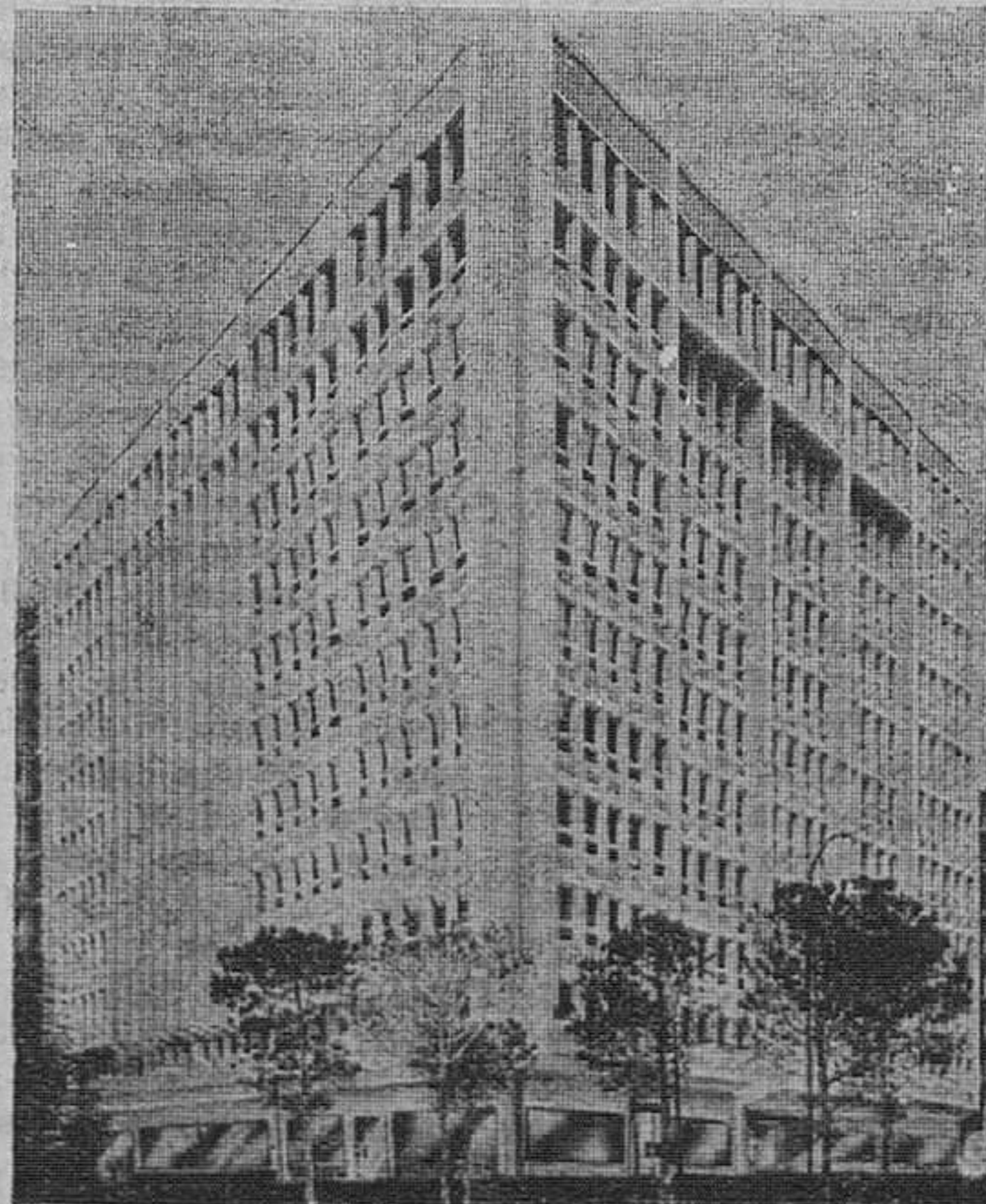
Edificio n.º 3. Av. Brasil, c/v a Pedro Texeira Madrid
