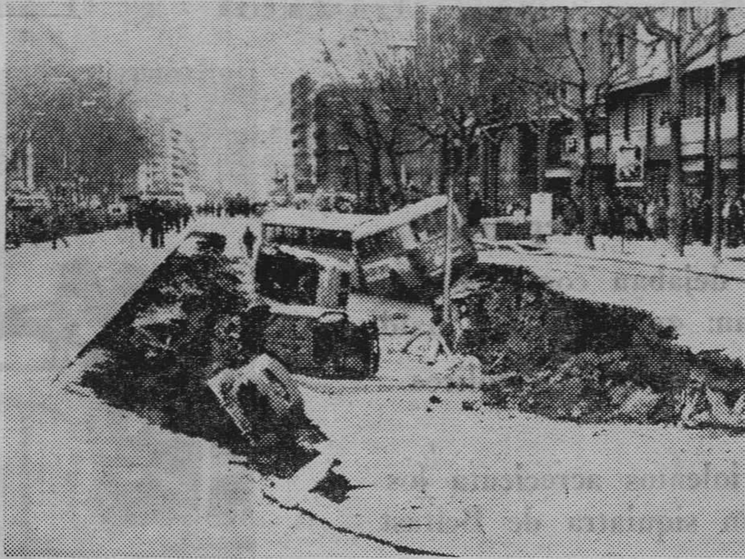
Barcelona. — Un socavón de unos 100 metros de longitud se produjo en la Avenida del Marqués del Duero, por causas que hasta ahora se ignoran. Un autobús articulado, tres turistas y dos camiones quedaron engullidos por el mayor socavón ocurrido en la Ciudad Condal. Por el momento hay que lamentar un muerto y tres heridos. — (Telefoto Cifra Gráfica)
