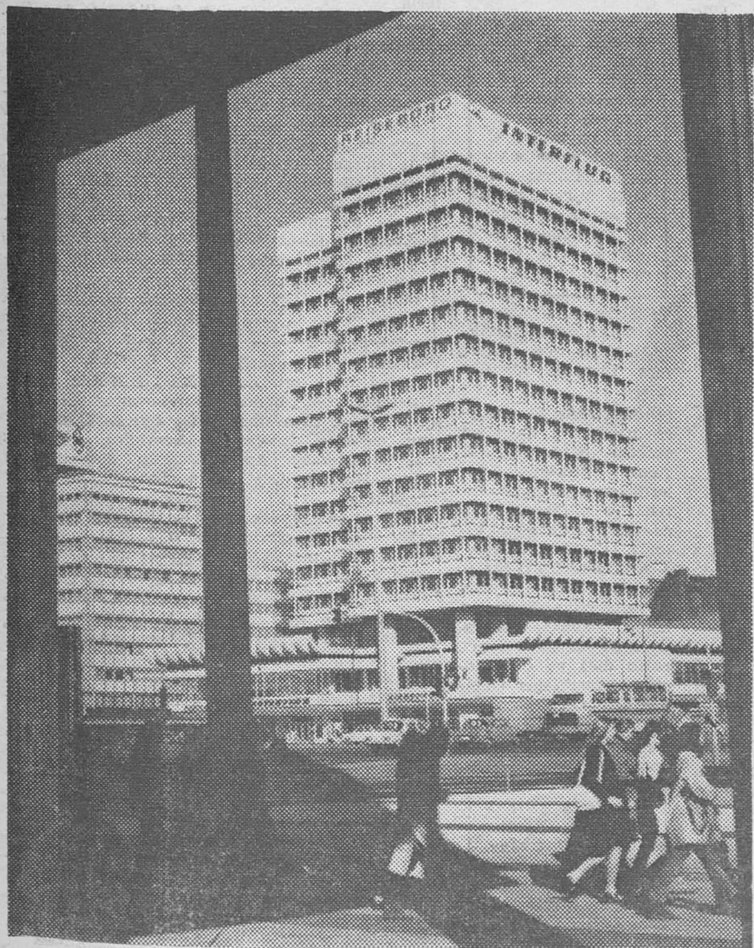
Cerca de la Alexanderplatz de Berlín, en la República Democrática Alemana, se ha levantado este edificio de 67 metros de altura, para sede de la Oficina de Viajes del país, así como para la compañía aérea Interflug. En este edificio se instalarán todos los servicios relacionados con los turistas extranjeros, oficina de pasaportes, bancos para el cambio de monedas, etc.—(Foto "Fiel")
