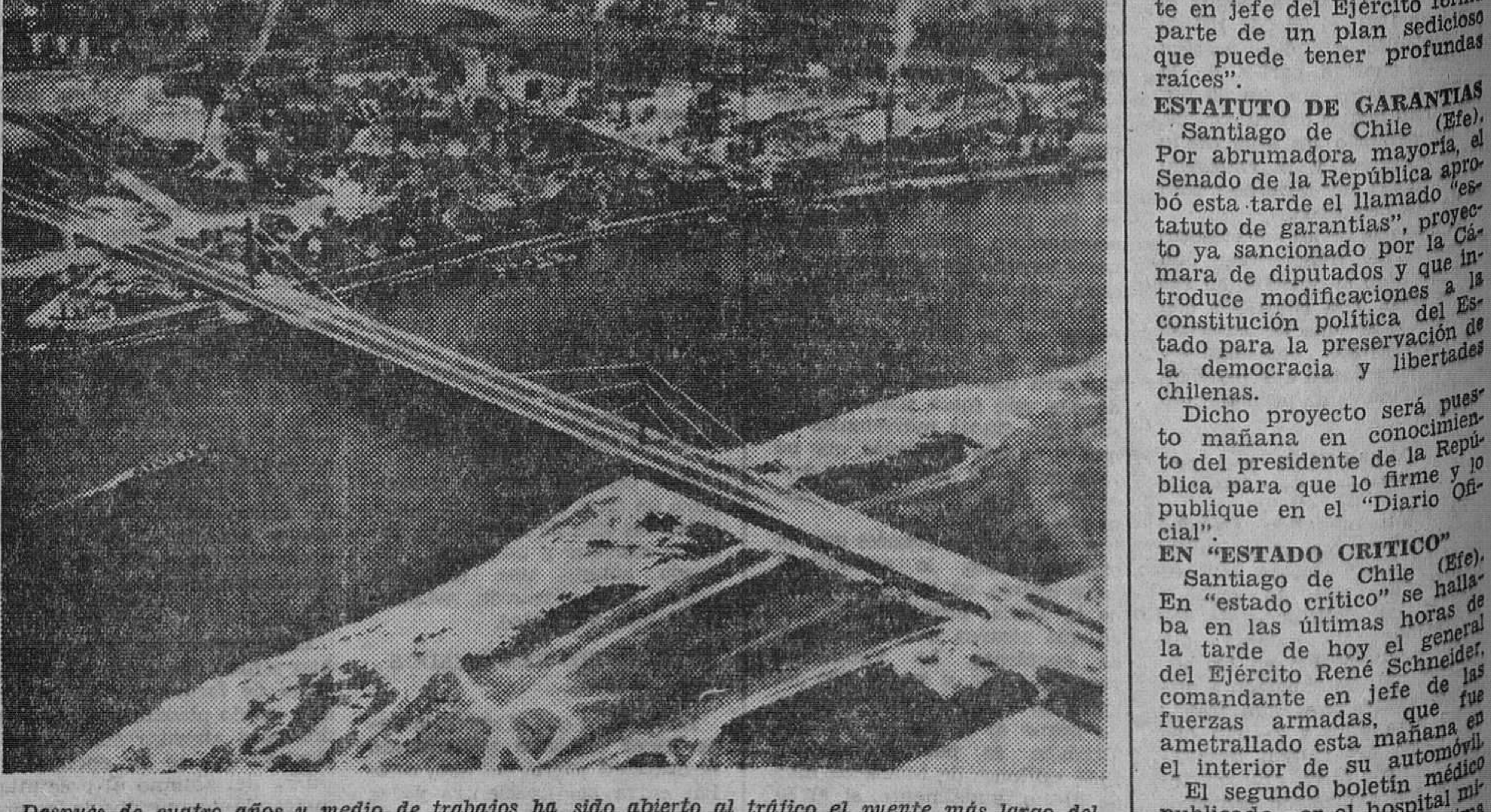
Después de cuatro años y medio de trabajos ha sido abierto al tráfico el puente más largo del Mundo sostenido por cables diagonales. Está vinculado a la autopista europea número 3 y cruza el Rhin en las proximidades de Duisburgo. Tiene 768 metros de largo, con tres carriles de tráfico en cada para peatones y una vereda para ciclistas y motocicletas. La autopista número 3 une la República Federal de Alemania con Francia, España, Portugal, Bélgica, Holanda, Dinamarca, Suecia y Noruega. En la foto vemos algunos aspectos del puente. — (Foto Fiel)
