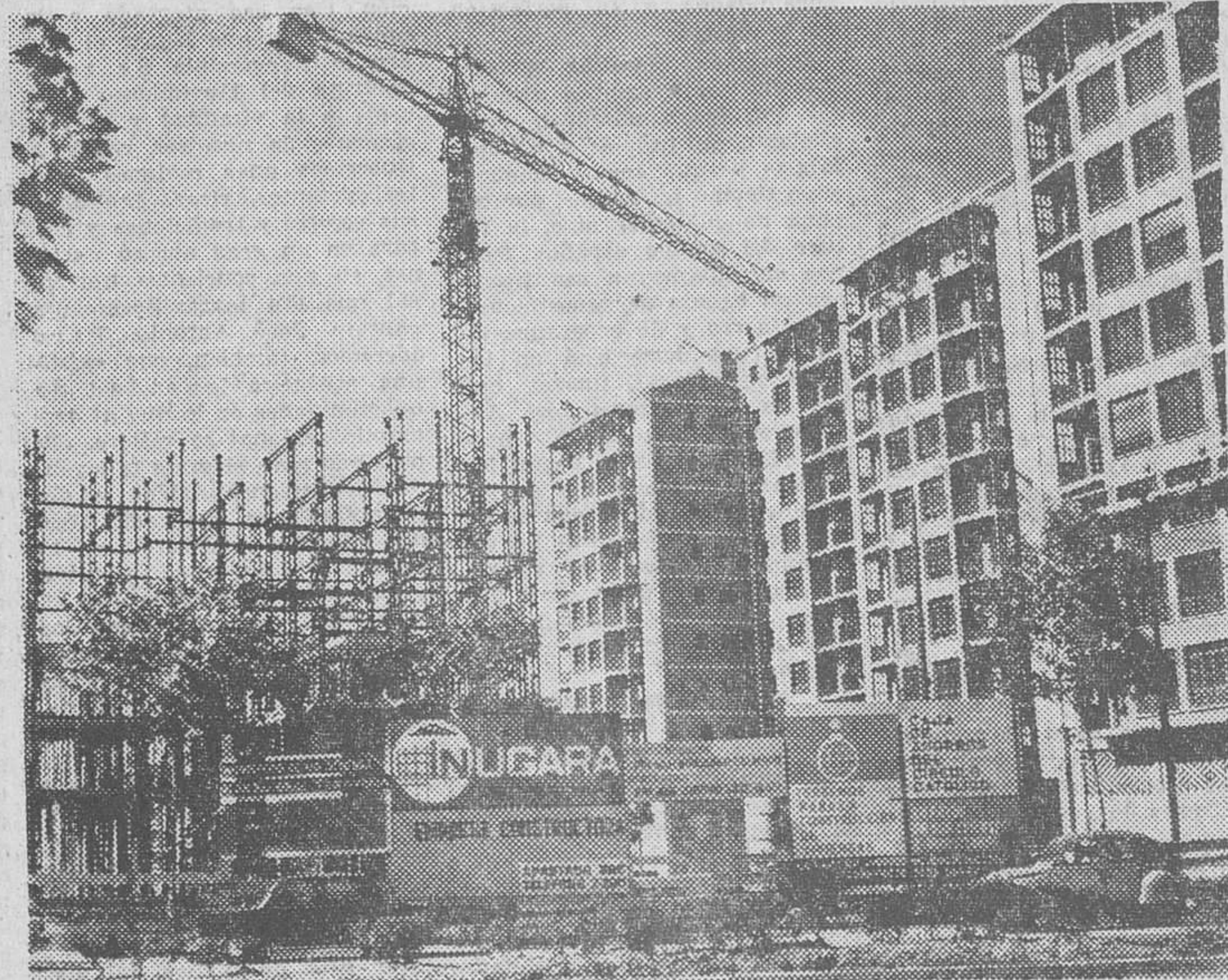
El esfuerzo constructor se desarrolla activo en el Polígono de la CAJA DEL CIRCULO. Bien lo prueba el grabado.
