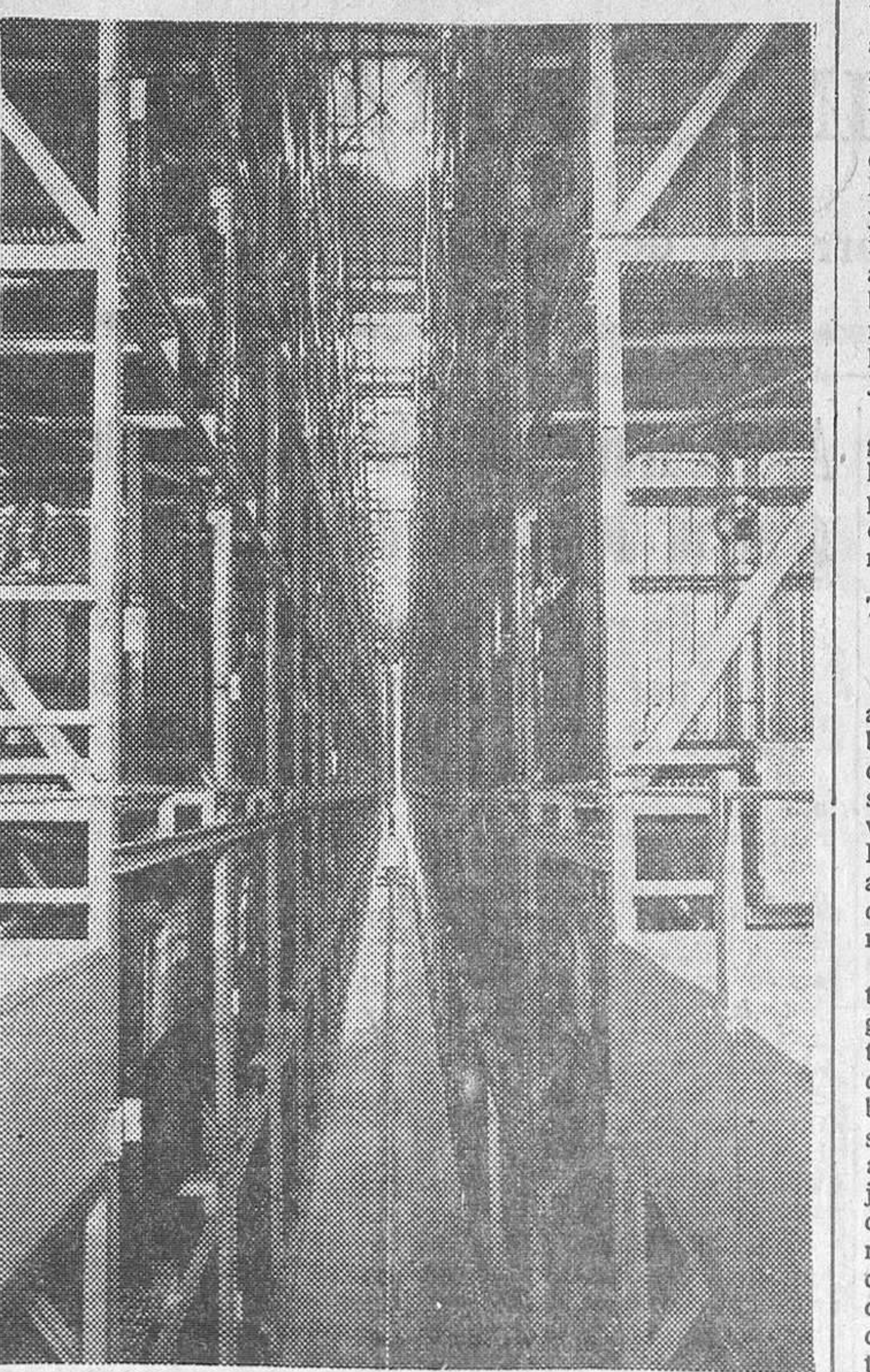
Un edificio que ha costado millón y cuarto de libras esterlinas ha sido entregado a la Pressed Steel Fisher en Castle Bromwich, no lejos de Londres. Se trata de una serie de naves en las que han sido instalados unos novísimos sistemas totalmente mecanizados para el almacenaje de diferentes piezas de automóviles. Recogidas e recipientes más o menos grandes son conducidas a unas estanterías, bajo control electrónico. Cuando se necesite cualquiera de ellas, sólo será necesario introducir una tarjeta perforada en un ordenador electrónico para que la caja correspondiente que las contiene venga automáticamente al lugar deseado. Las naves tienen capacidad para más de diez mil de estos recipientes. En la foto vemos un aspecto de ellas. — (Foto Fiel)
