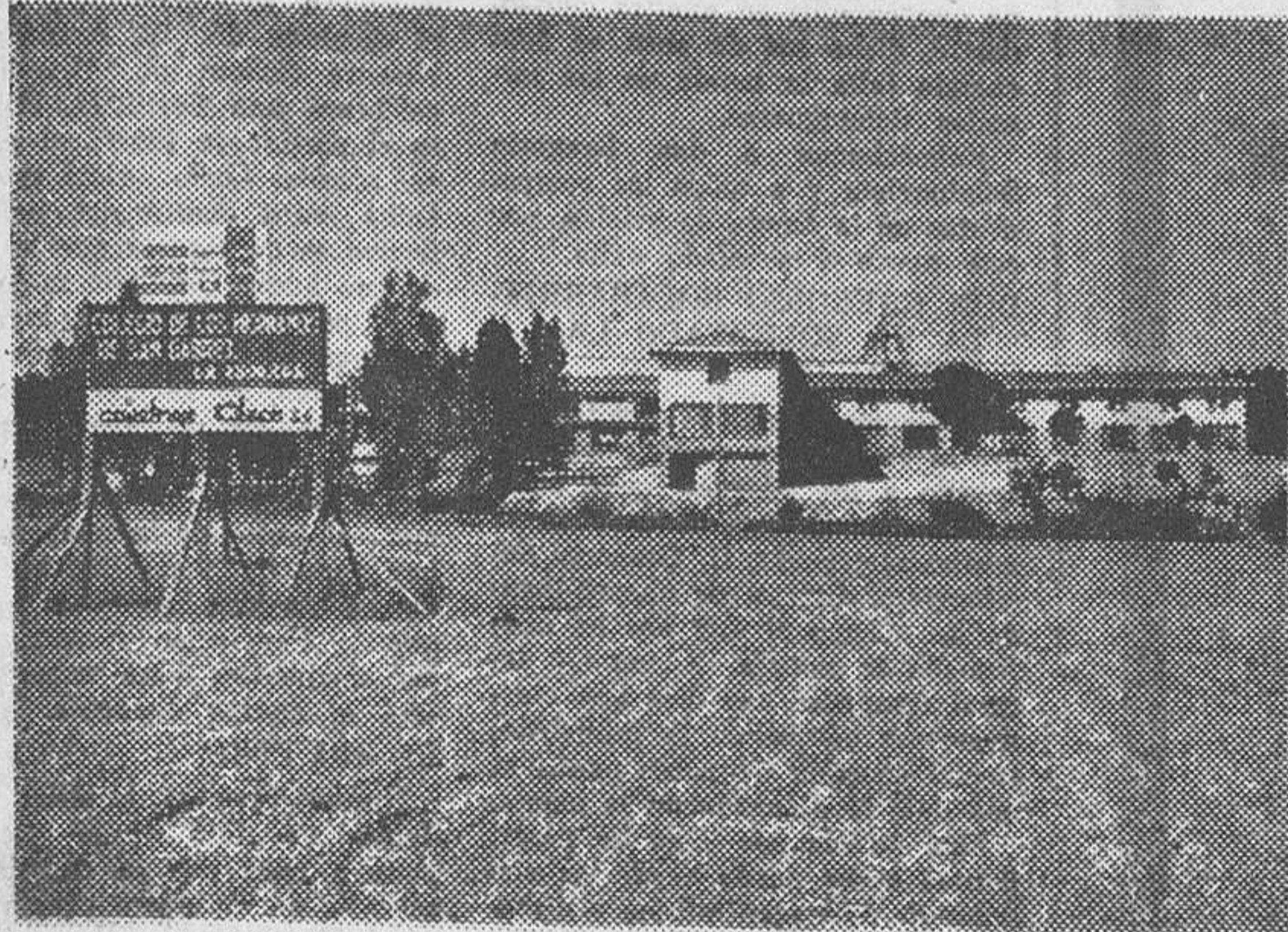
Vista de la fachada principal del edificio de los Hnos. Gabrielistas desde la carretera. — (Foto Díaz)
