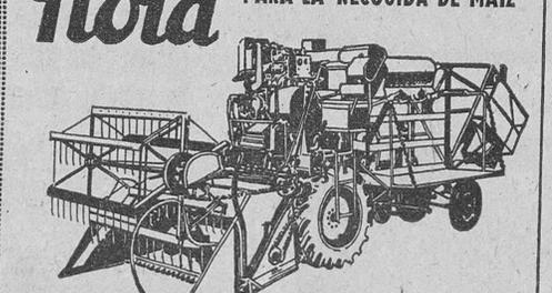
Modelo COMBI de 2,10 m. de corte con motor Fordson de 49 HP.
