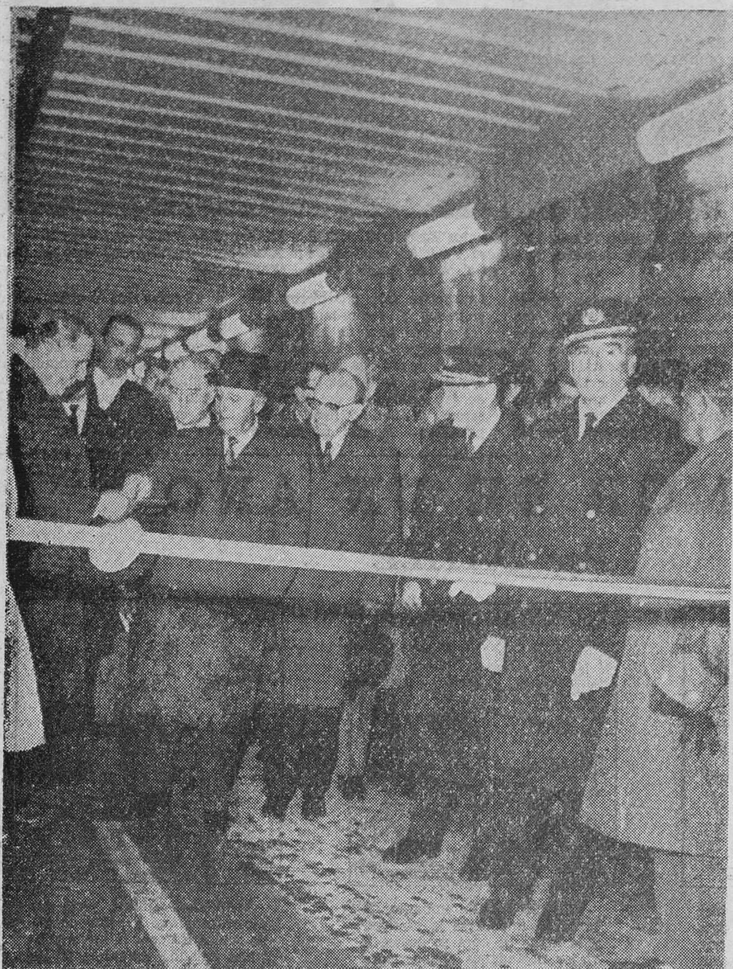
Su Excelencia el Jefe del Estado en el acto oficial inaugural del Túnel de Guadarrama, la primera carretera de peaje española.—(Foto Cifra).
