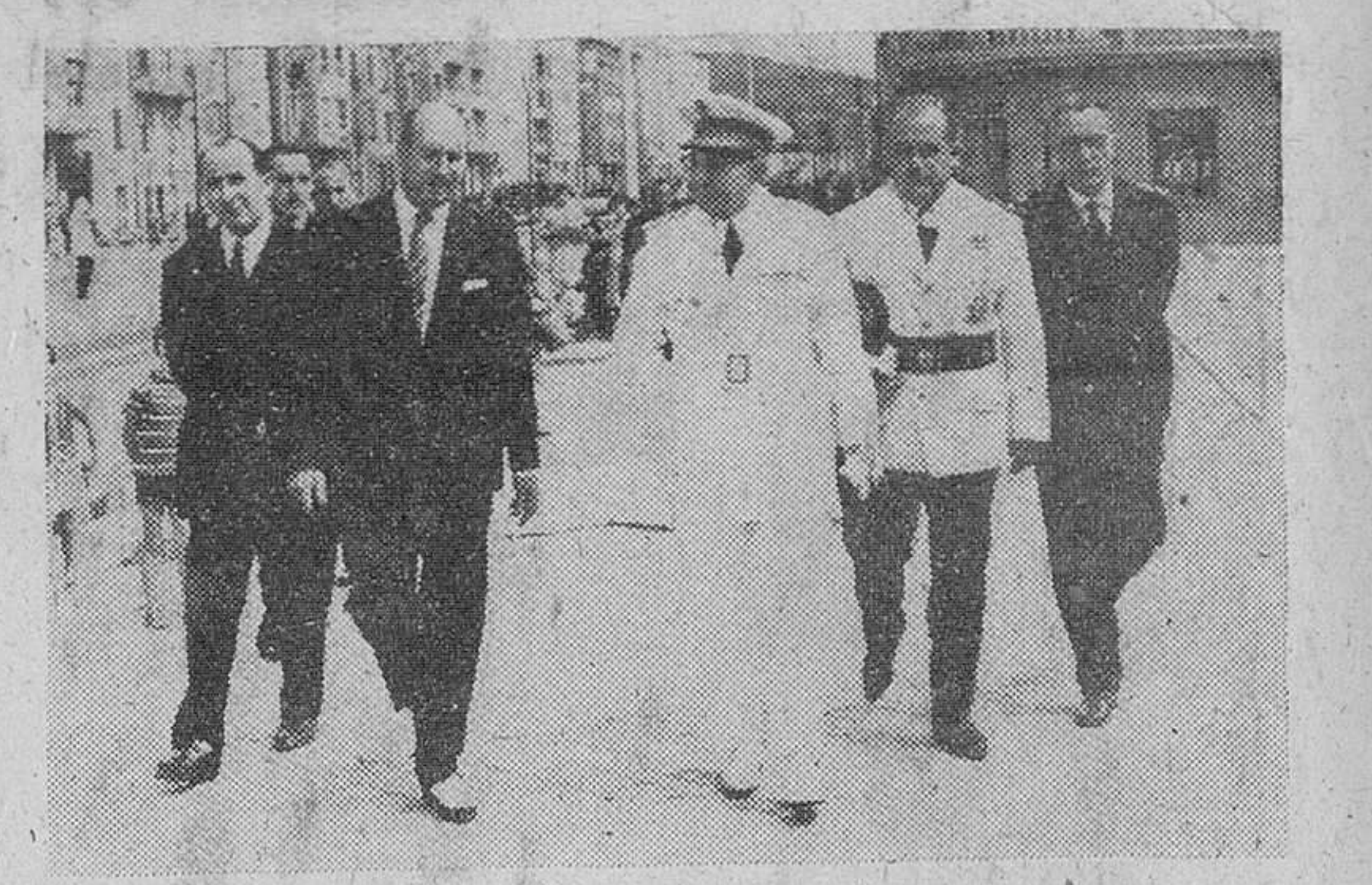
El Excmo. ministro de Obras Públicas, Sr. Vigón, acompañado del director general de Carreteras; alcalde de Burgos; ingeniero jefe de Obras Públicas, Sr. Sánchez y del ingeniero de Caminos al servicio del Ayuntamiento, Sr. Plaza, durante la detenida visita que giró en la mañana de ayer al antiguo edificio del Instituto de Higiene, en la Avenida del Cid Campeador.—(Foto Fede).
