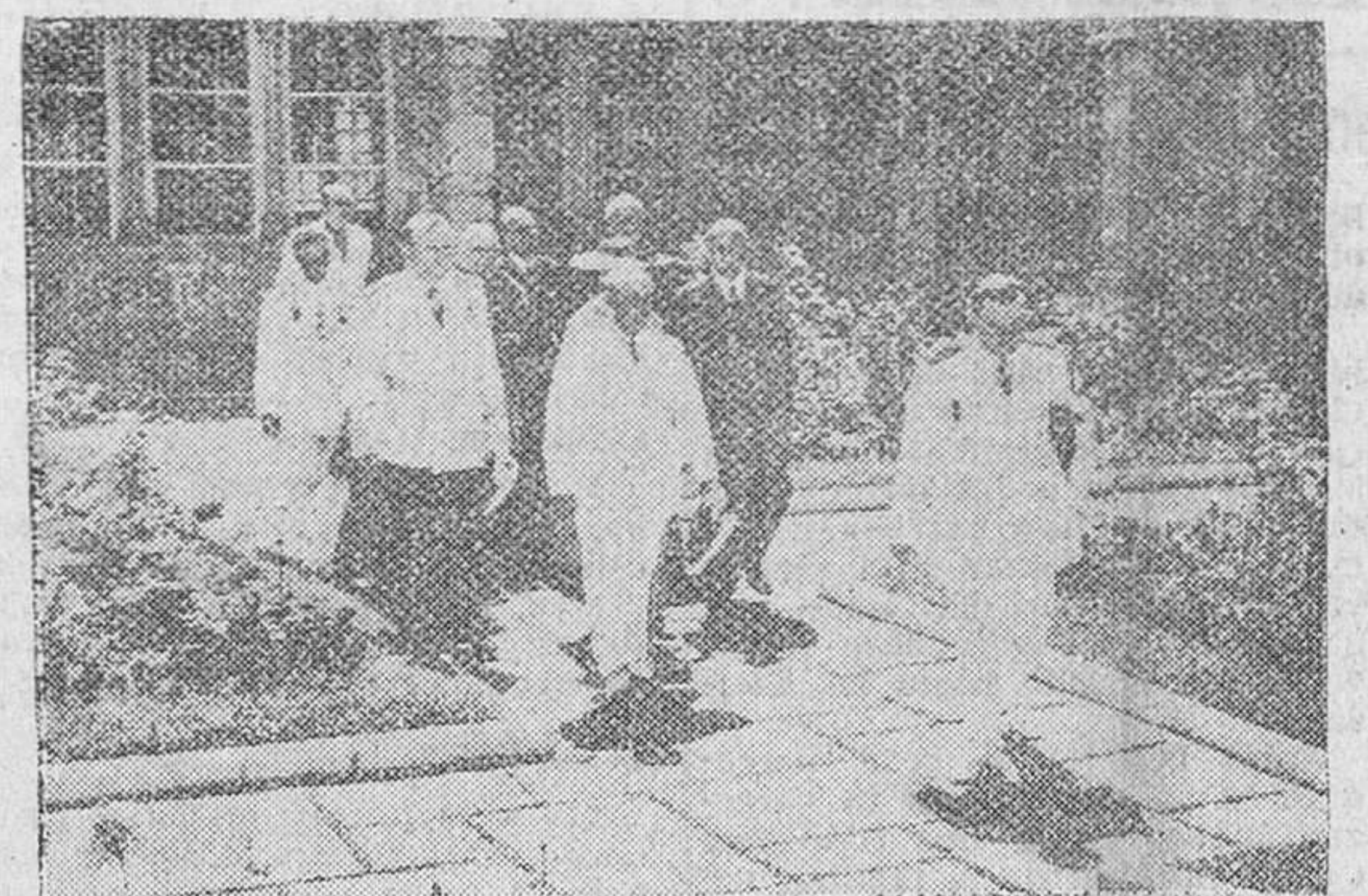
Santander. — S. E. el Jefe del Estado, acompañado del director de Regiones Devastadas, obispo y otras personalidades, recorriendo los patios de la Catedral reconstruida, después del incendio de 1941 que la destruyó, y que ha sido entregada oficialmente a la ciudad. — (Foto Cifra)
