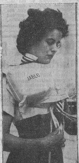
El nuevo chaleco salvavidas confeccionado de material plástico "aeroblast", de gran poder de flotación, que acaba de ser ensayado en Inglaterra con pleno éxito, pesa menos de un kilo y sostiene perfectamente a una persona dentro del agua.
