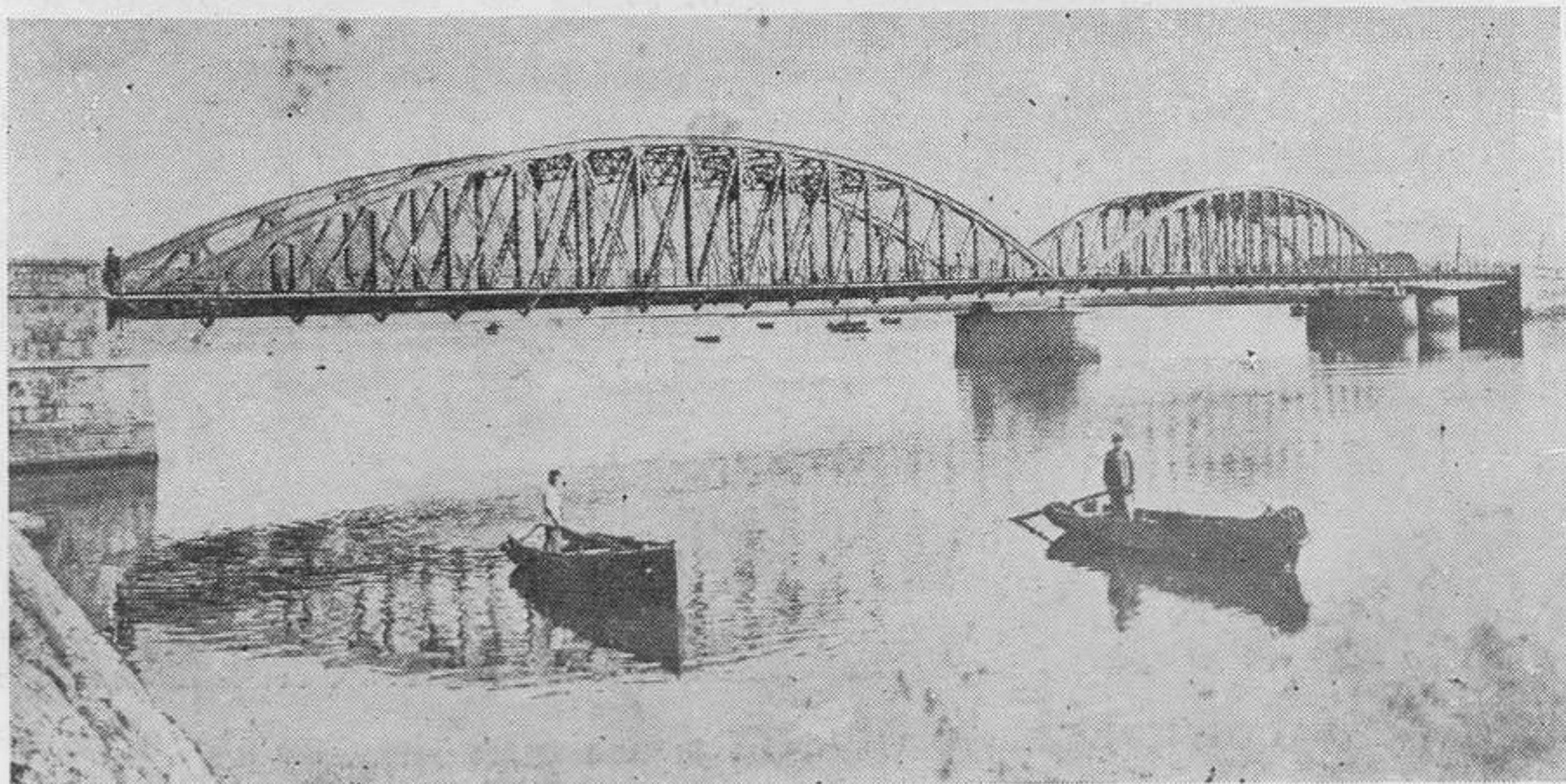
COLINDRES.—Otro exponente del progreso de esta industriosa villa montañesa es el Puente Giratorio, complicada y notable obra de ingeniería, que facilita el paso terrestre sobre el mar.
