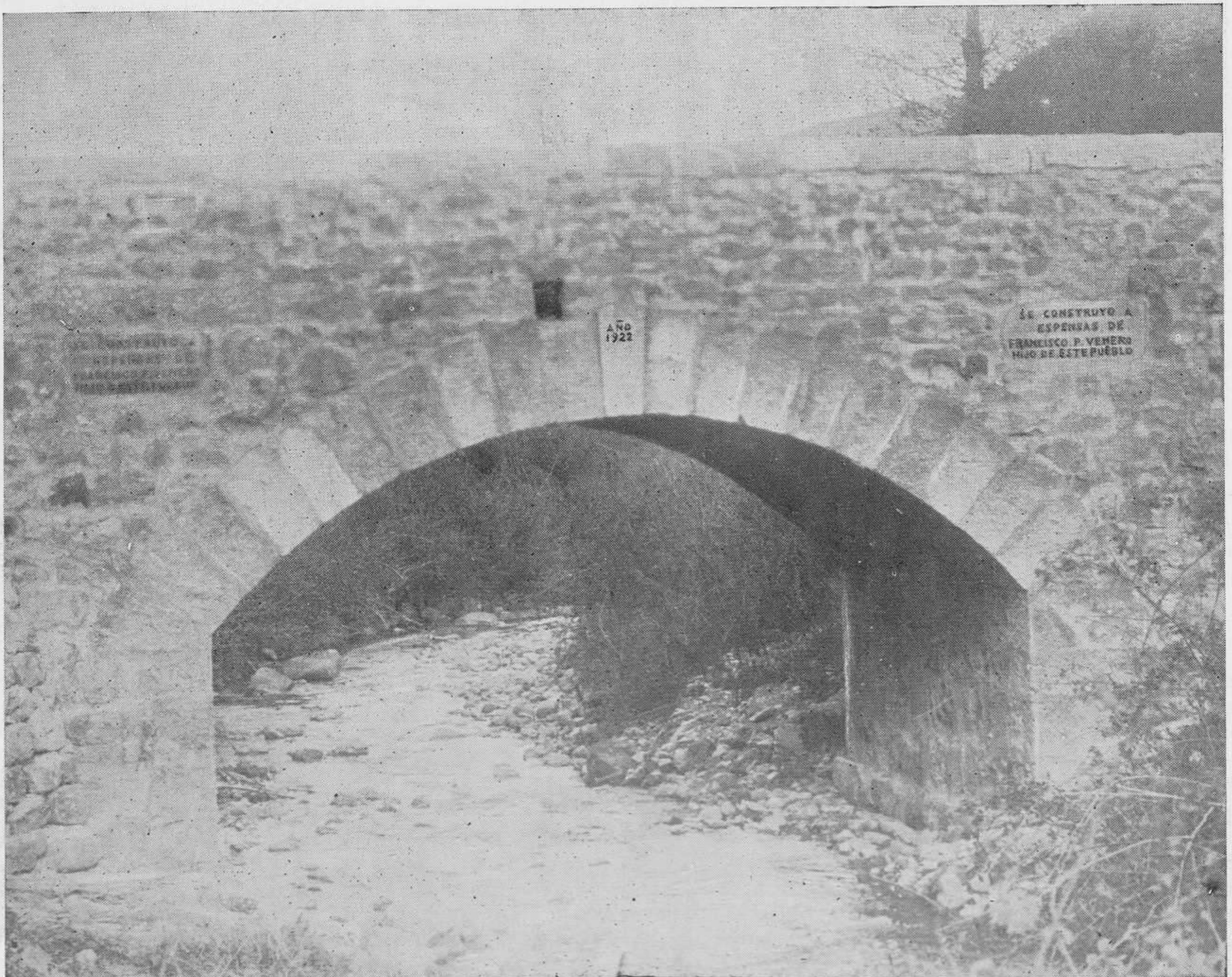
Aspecto del puente.
