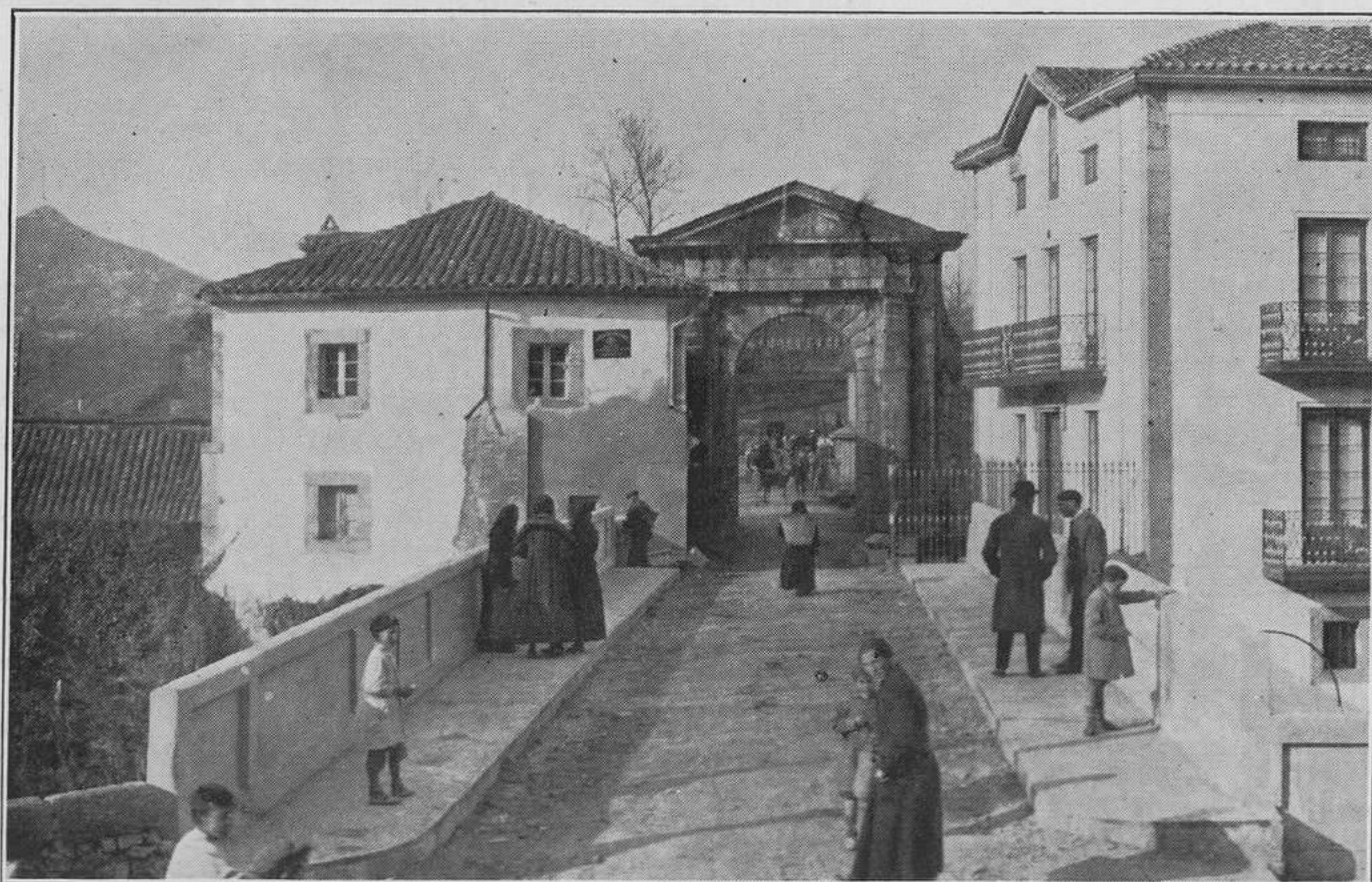
LA CAVADA.—El puente sobre el río Miera, después de su reparación.
