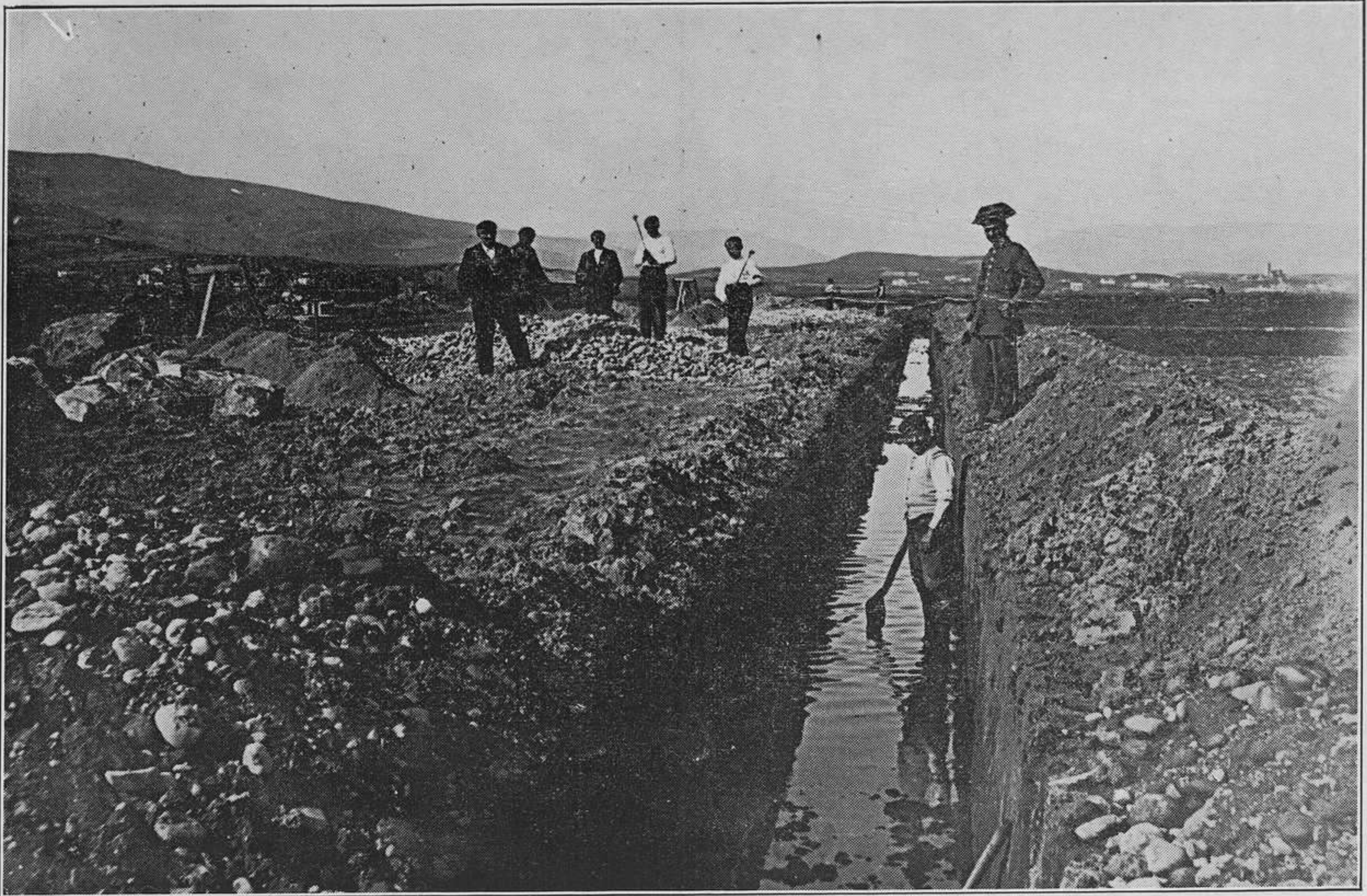
REINOSA.—Vista de los primeros trabajos para la factoría que va a establecer la Sociedad Española de Construcción Naval. (Fot. R. Salceda.)
