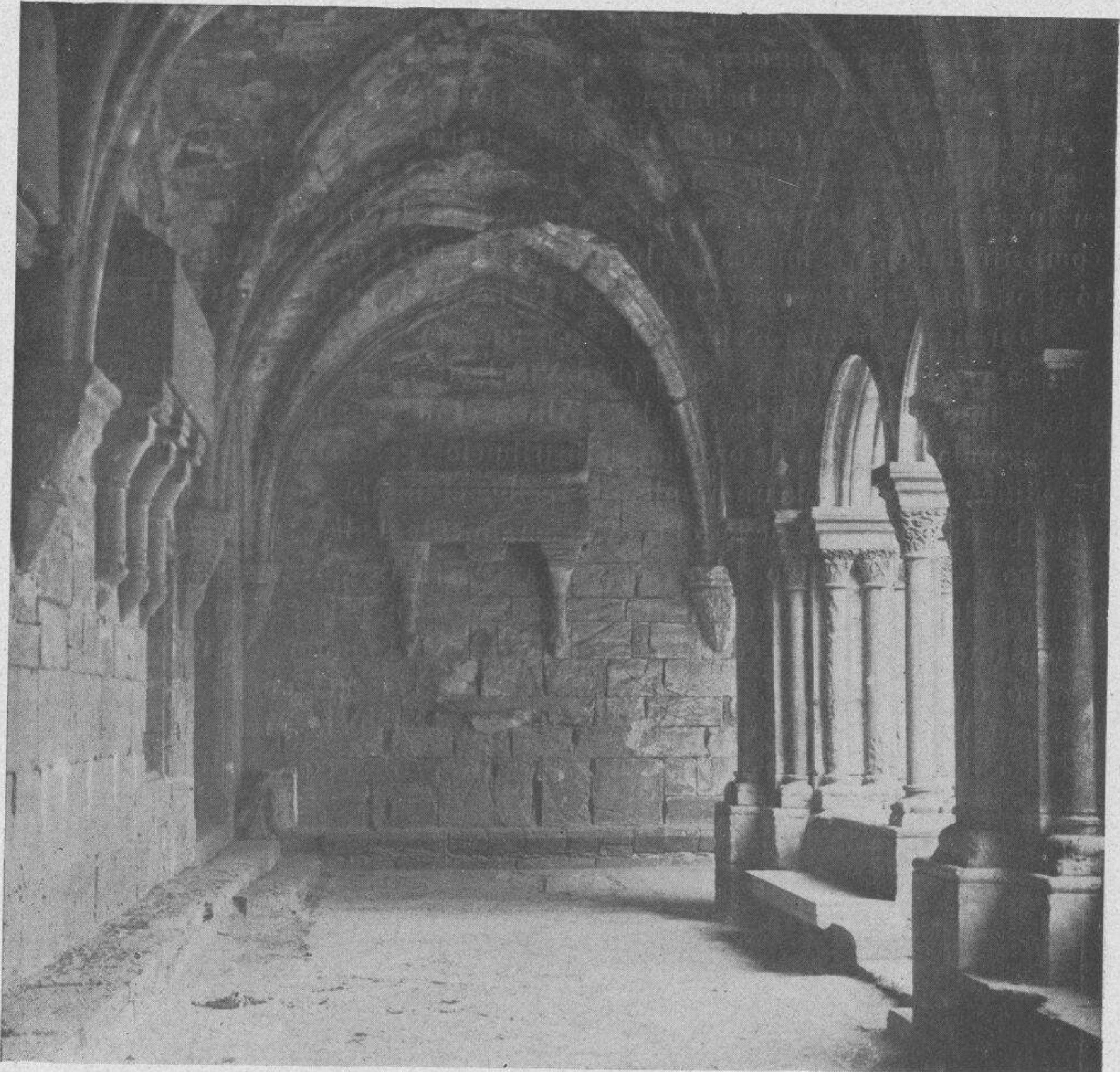
Ala antigua del Claustro, contigua a la iglesia.
