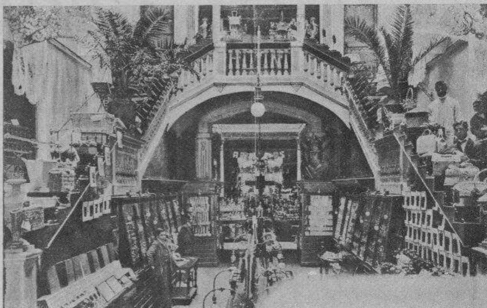
EL SIGLO : Sección de Bisutería (planta baja).
