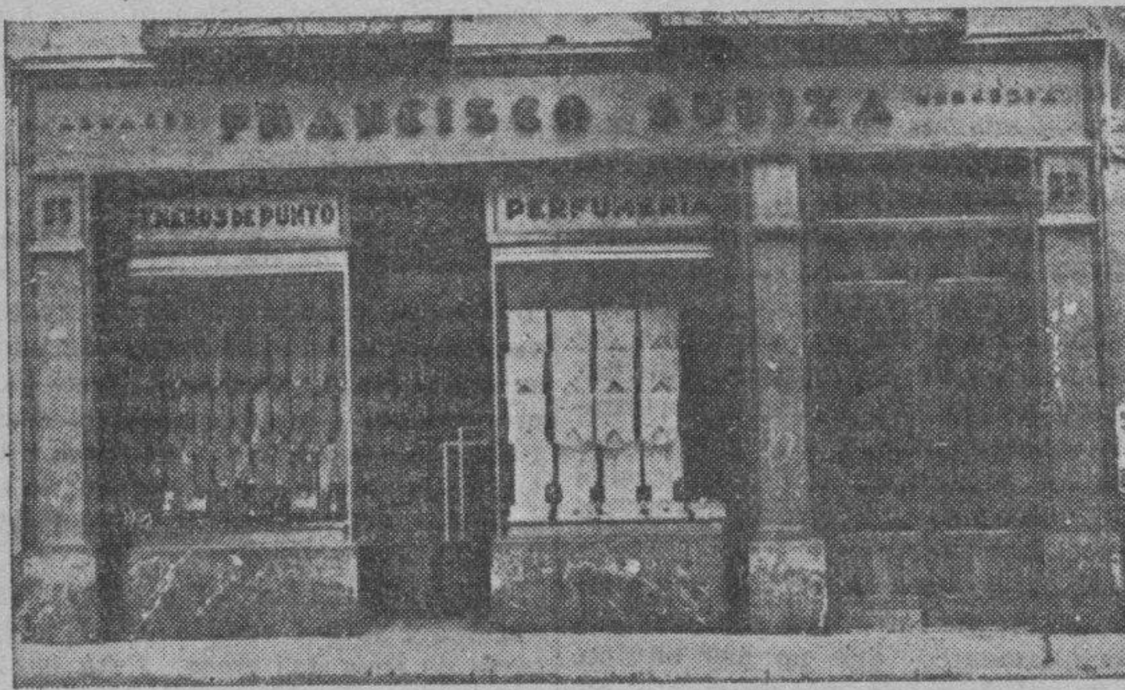
Un aspecto de la fachada de los populares ALMACENES SUBIZA, instalados en la calle de San Pablo.
