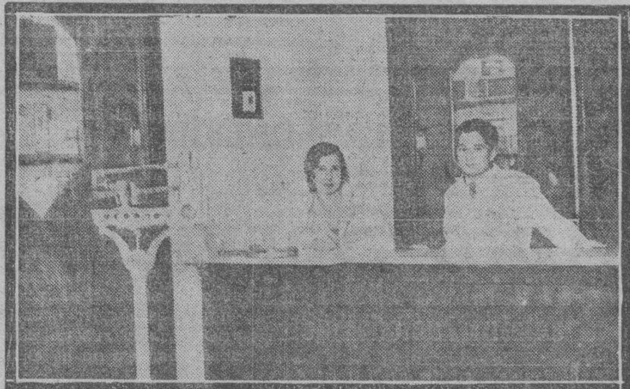
MUTUALIDAD SANITARIA DE TRABAJADORES ha establecido para el mejor servicio de sus asociados una farmacia propia en la calle Candalla, número 3. Ofrecemos a nuestros lectores un detalle de la excelente instalación de este servicio.
