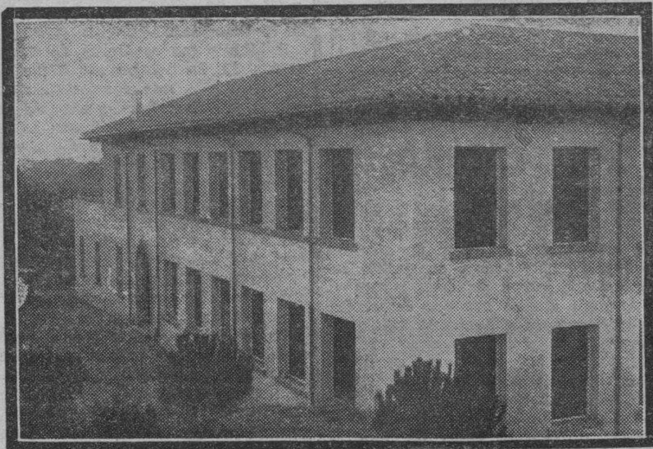
Aspecto del preventorio del Cabezo Cortado, después de las obras de ampliación que en él se han llevado a efecto.
