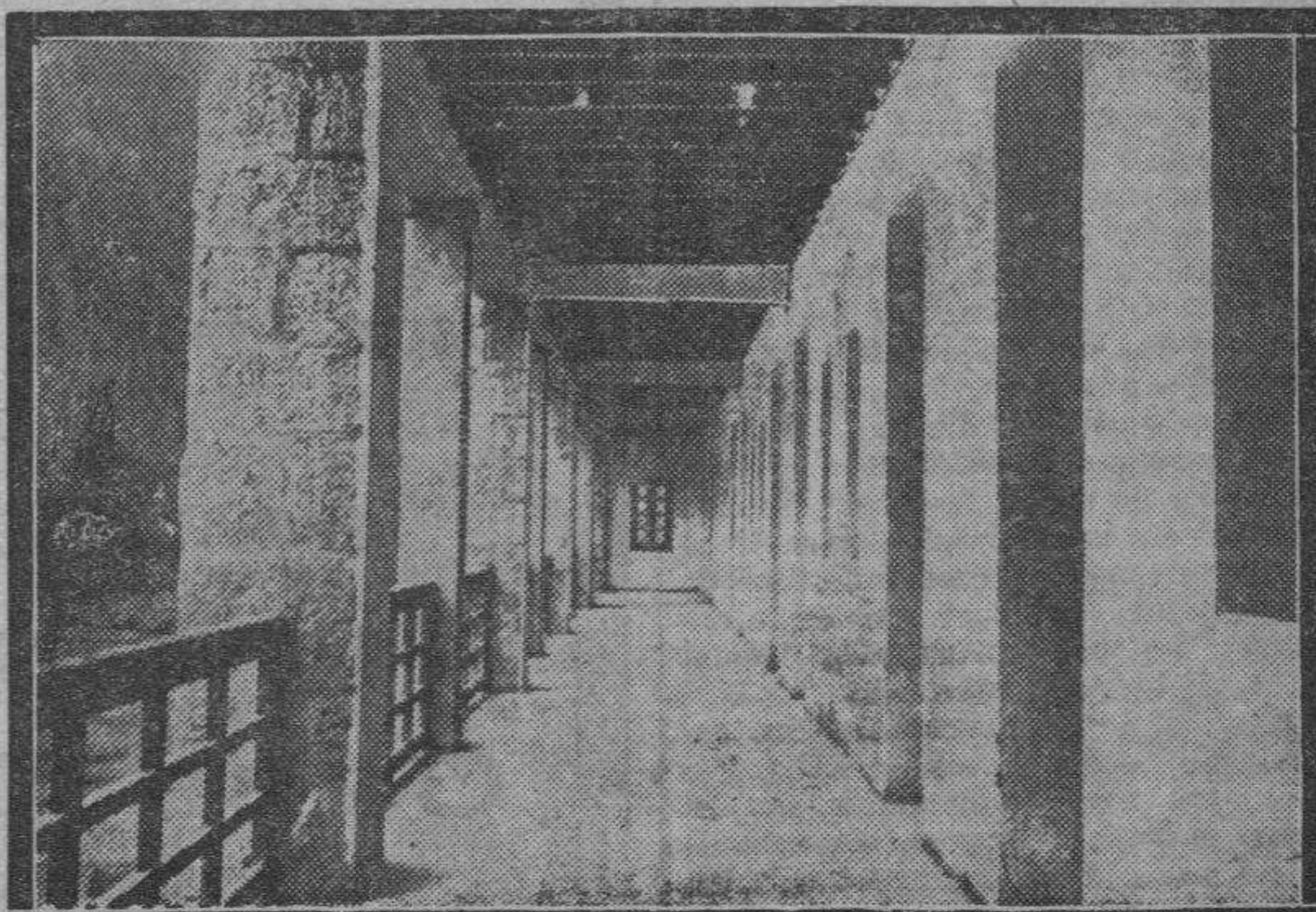
Una galería de aireación y soleación del Sanatorio de Pineta.
