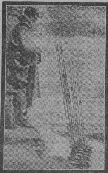
Las seis escaleras de que disponen los bomberos de París para escalar los edificios siniestrados, montadas sobre plataformas móviles para su traslado rápido a cualquier punto. Cada una de las escaleras reproducidas en la foto mide treinta metros de altura.
