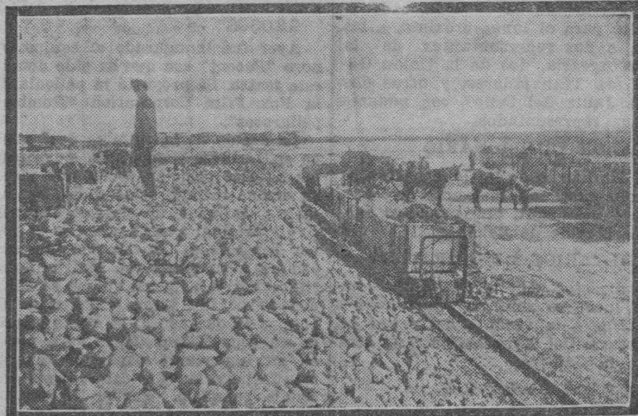
Traída de las huertas al cargadero; un diminuto ferrocarril transporta la remolacha en breves minutos a la Azucarera.
