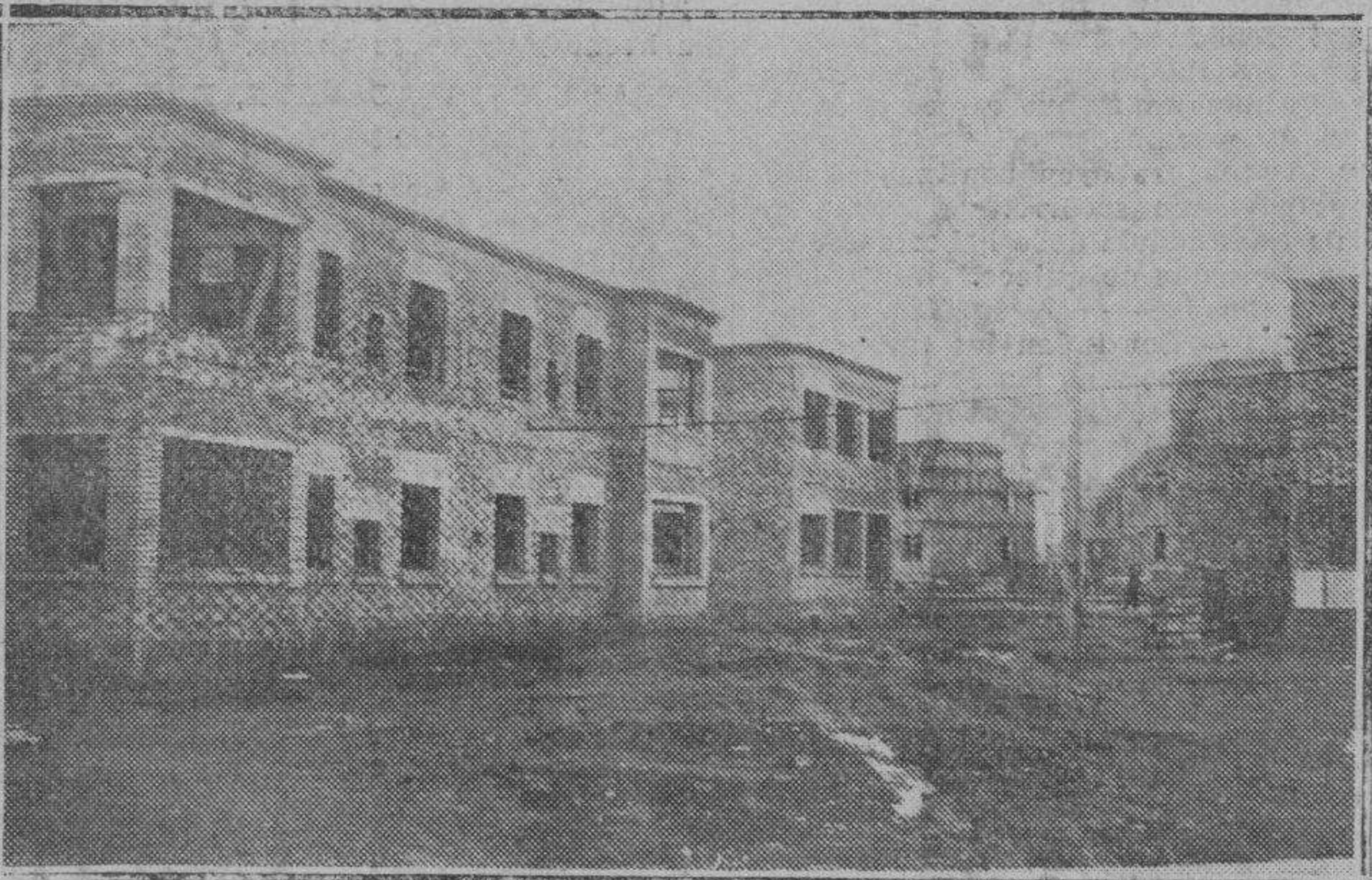
Hoteles en construcción, tipos heterogéneos, que dan un aspecto vario a este sector de la futura Zaragoza
