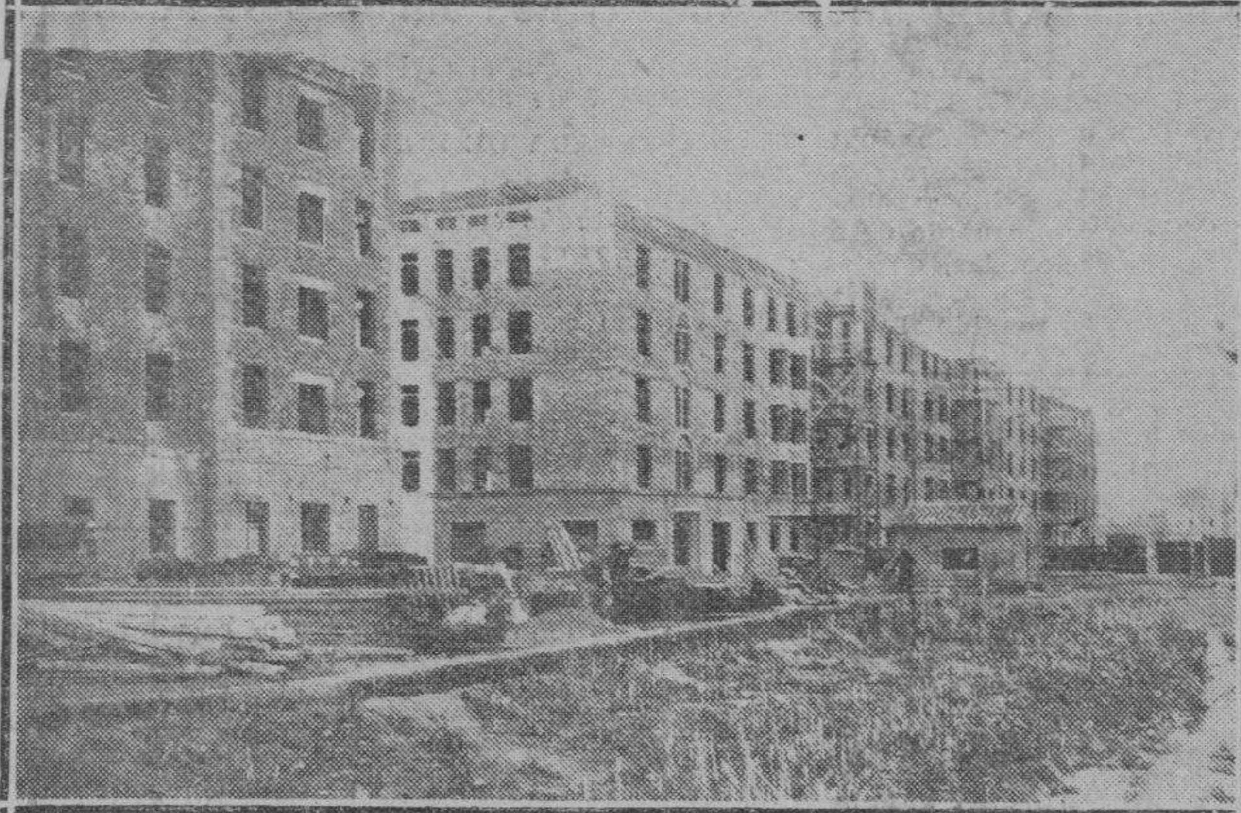
En pocos meses han surgido estas manzanas de casa de vecindad, que son un avance de las que hay proyectadas en la extensa zona.
