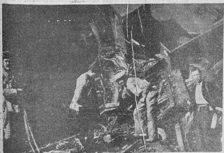
Un aspecto del descarrilamiento de un tren de mercancías, ocurrido entre las estaciones de El Bazar y La Solana de los ferrocarriles Andaluces, originado por el desprendimiento de una trinchera. A consecuencia de la catástrofe resultaron muertas tres personas y heridas gravísimamente otras varias, falleciendo después otros dos ferroviarios
