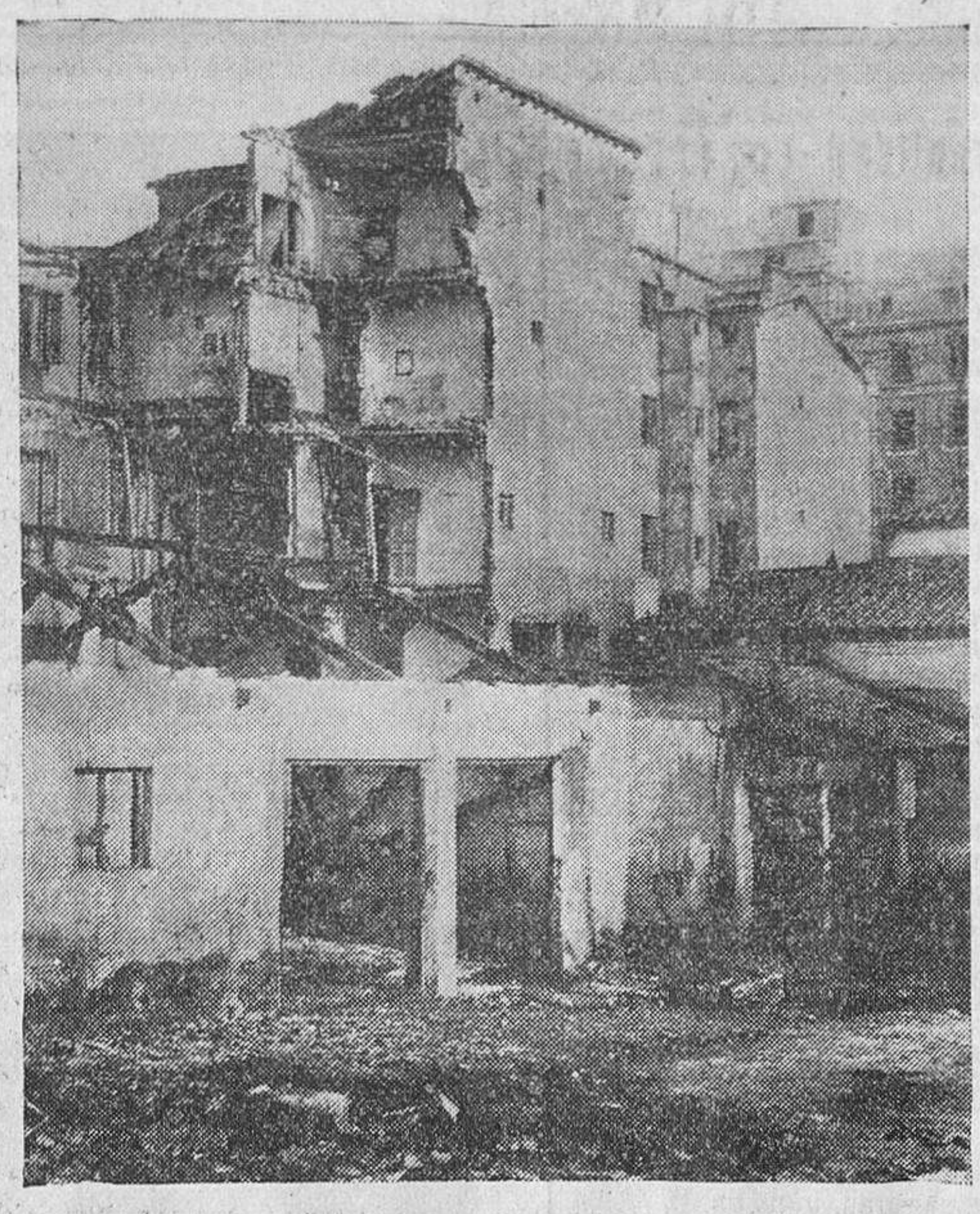
En la calle de Bravo Murillo, el martes se derrumbó repentinamente toda la pared posterior de las casas señaladas con los números 28 y 30 de citada calle. La "foto" recoge el estado en que quedaron ambas casas después del derrumbamiento
