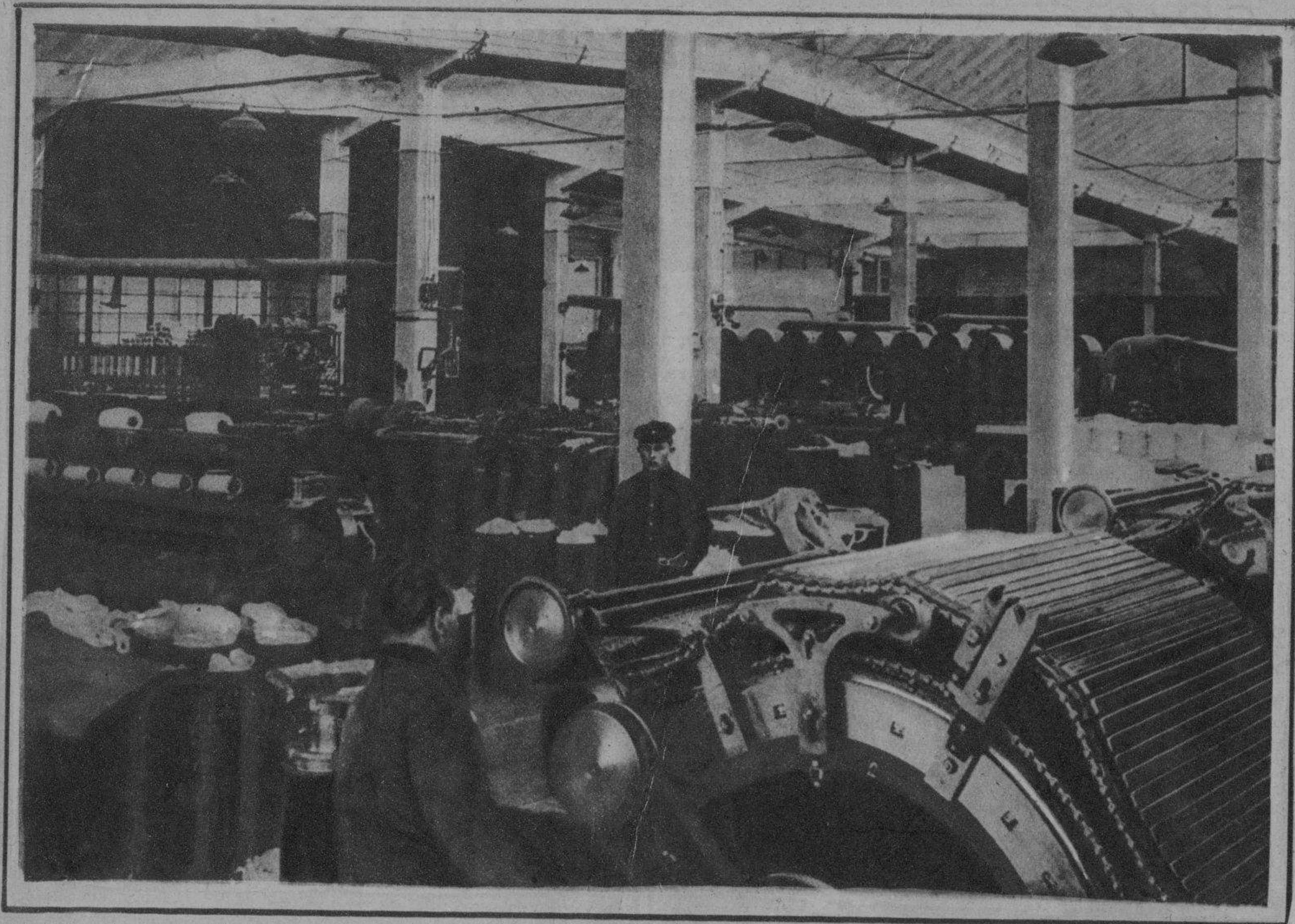
Aspecto de una sala de maquinaria soviética
