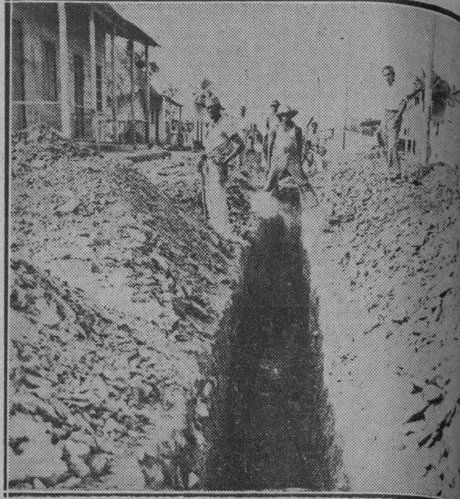
Las obras del alcantarillado en Guantánamo.—Dos calles en la parte Norte de la Ciudad, donde comenzaron los trabajos y en la que se ve la zanja abierta en medio de la calle para recibir las tuberías otra en la que se aprecian varios tubos de los que se están empleando.
