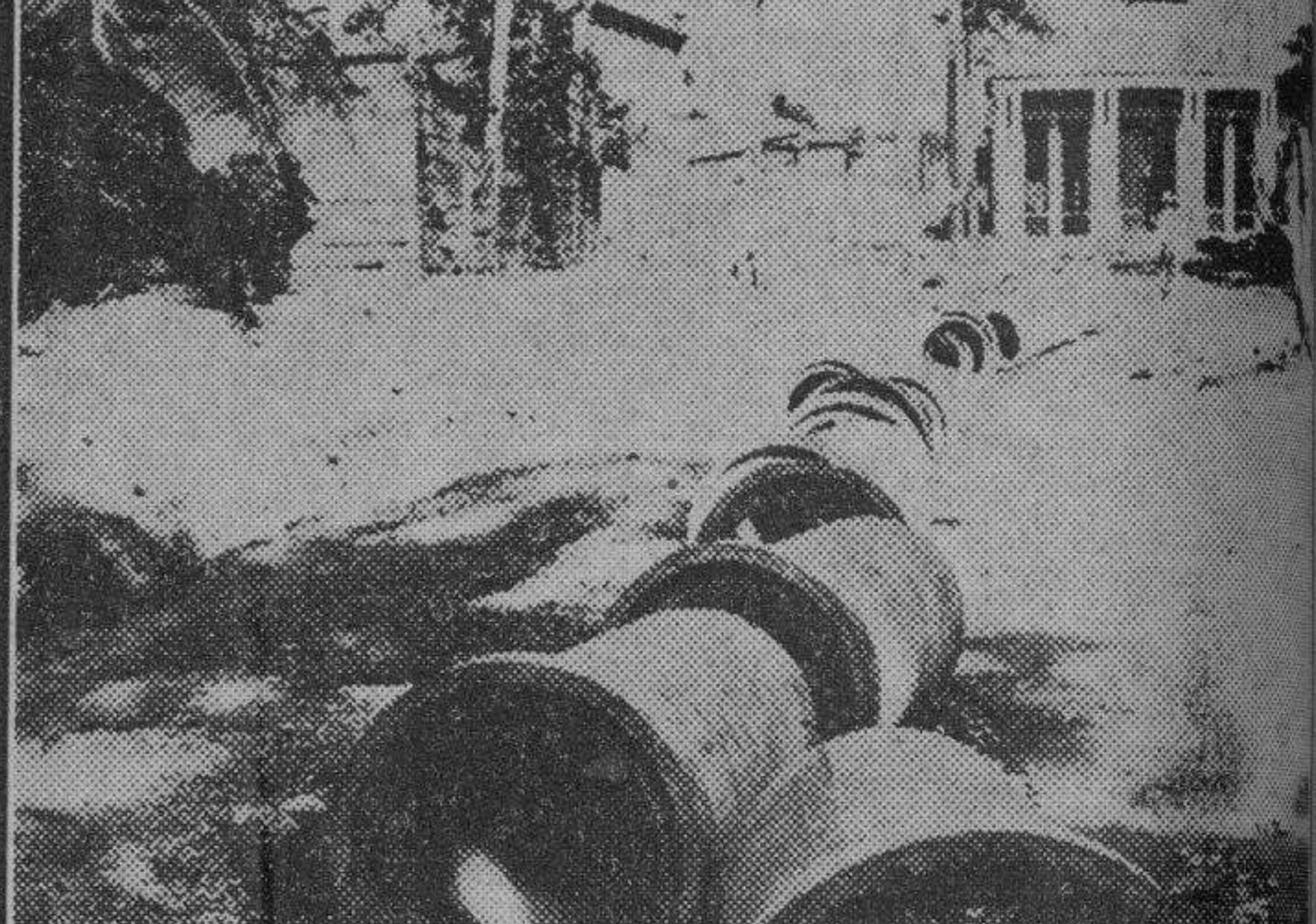
Las obras del alcantarillado en Guantánamo.—Dos calles en la parte Norte de la Ciudad, donde comenzaron los trabajos y en la que se ve la zanja abierta en medio de la calle para recibir las tuberías otra en la que se aprecian varios tubos de los que se están empleando.
