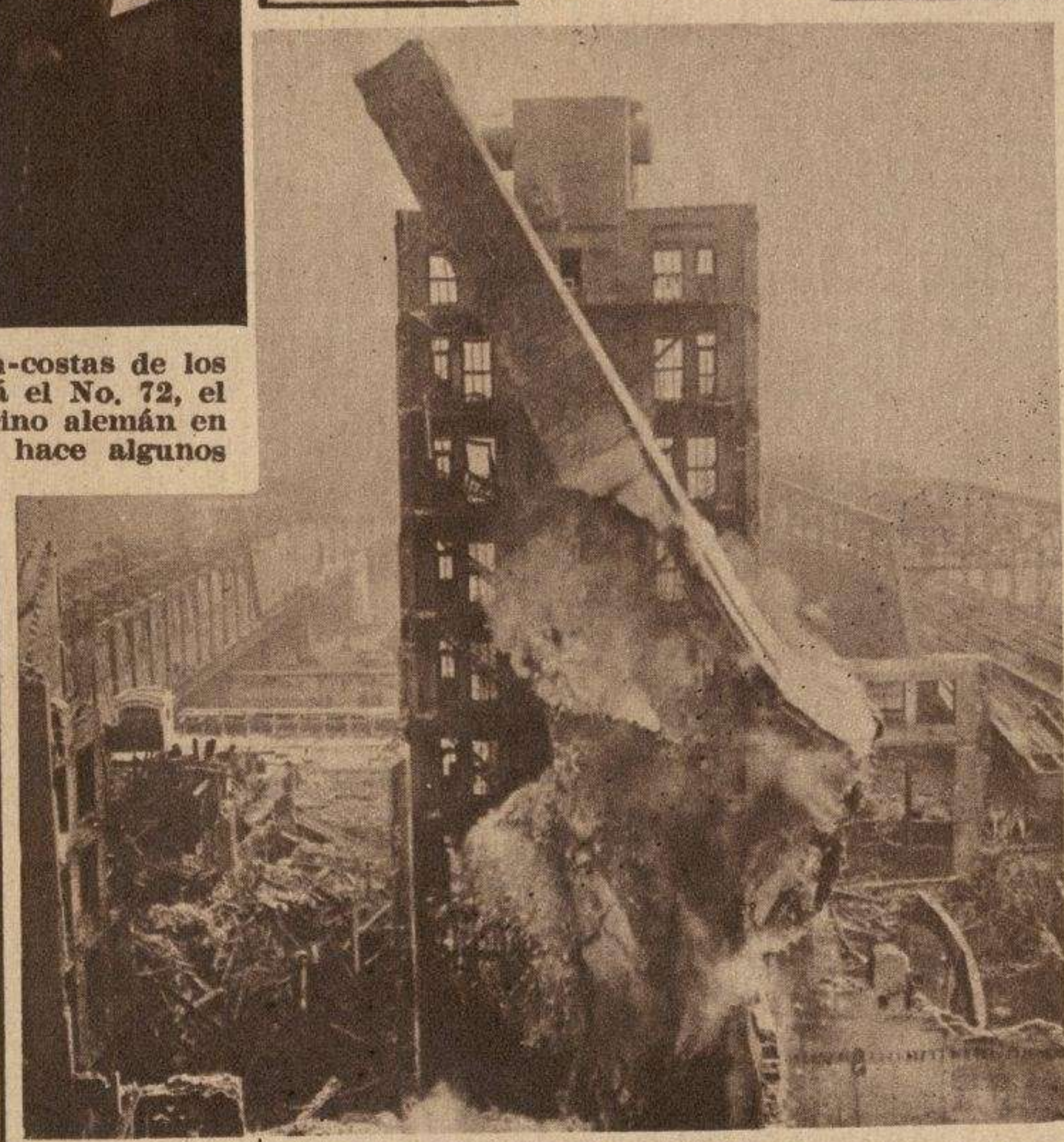
Esta instantánea ha sido tomada en el momento preciso que una carga de dinamita hace explosión, derribando una chimenea grande que quedaba en el medio de las ruinas causadas por la última conflagración de Chicago, que costó unos diez millones de dollars de pérdidas.
