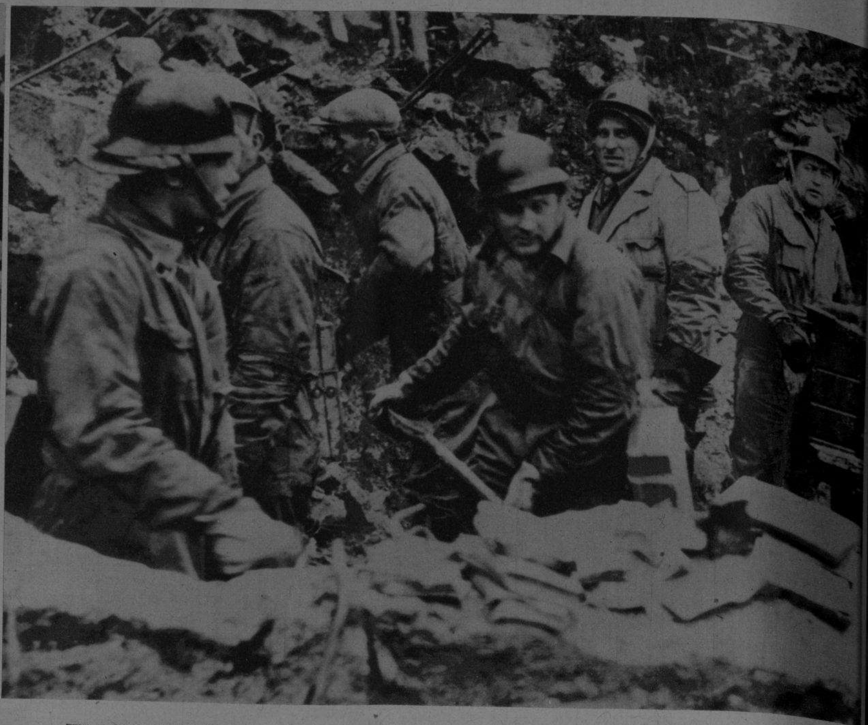
UN DESTACAMENTO de bomberos de la ciudad de Helsinki (capital de Finlandia) rindiendo su labor de búsqueda de víctimas y de escombros después de un raid aéreo ruso contra la capital. (Foto Wide)
