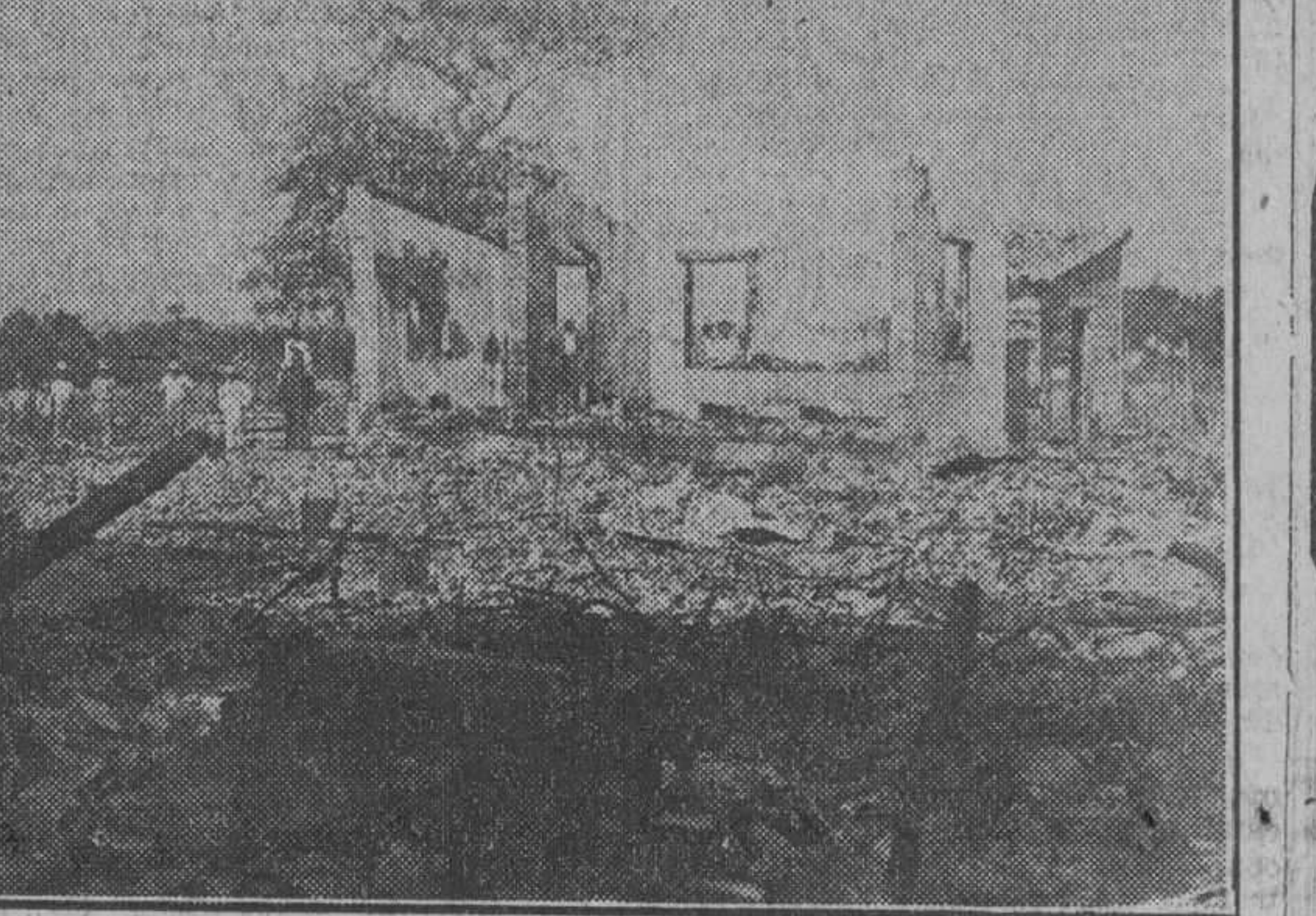
Aspecto parcial de las ruinas del que fué Asilo de Ancianos "San José", en Pinar del Río, destruido por un incendio en la noche del 23 de Abril.
