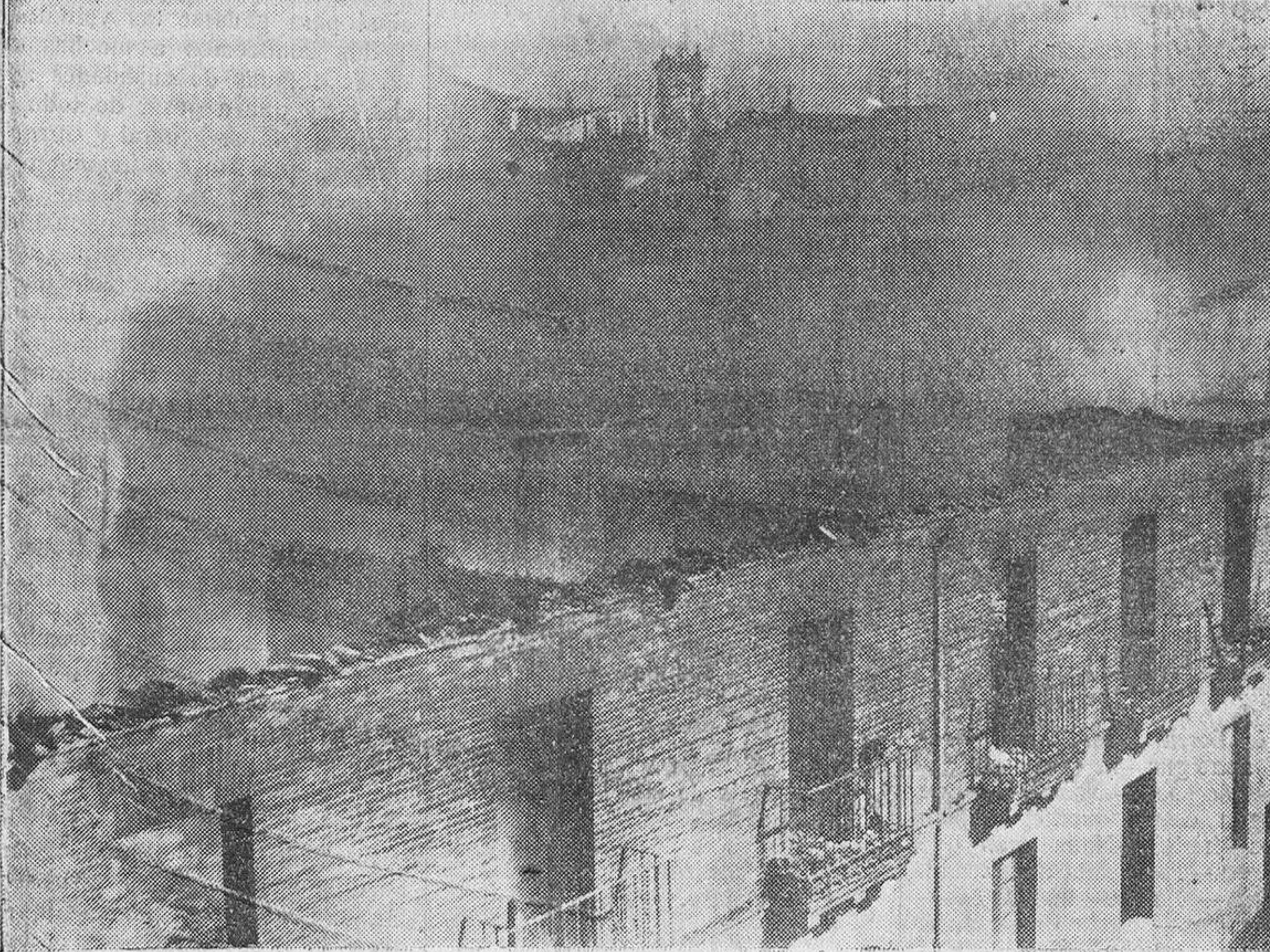
Arriba: Fachada posterior del edificio siniestrado, en la calle de Espoz y Mina.—Abajo: Los techos hundidos, las paredes desplomadas y el humo ascendiendo en espesas nubes.
