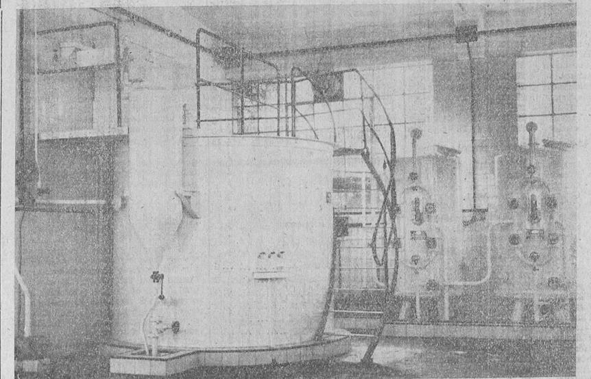
La primera fase del tratamiento del agua comienza en el tanque, con la destrucción de las materias orgánicas en suspensión contenidas en el líquido, siguiendo luego su clasificación total. Entra después el agua en las dobles y potentes barreras de filtros, impidiendo el paso de gérmenes nocivos, reactivándose el proceso de purificación absoluta con separación del cloro
