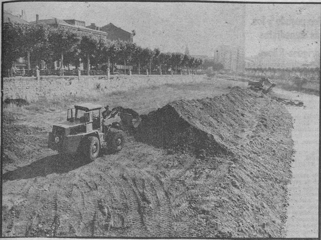
Estos días se están llevando a cabo importantes obras de encauzamiento del río Arlanzón entre los puentes de Castilla y Santa María. Se trata de suprimir los meandros que forman las aguas y que estaban socavando algunos tramos del malecón del paseo de la Isla. Los trabajos tienen un interés singular. (Foto Villafranca)
