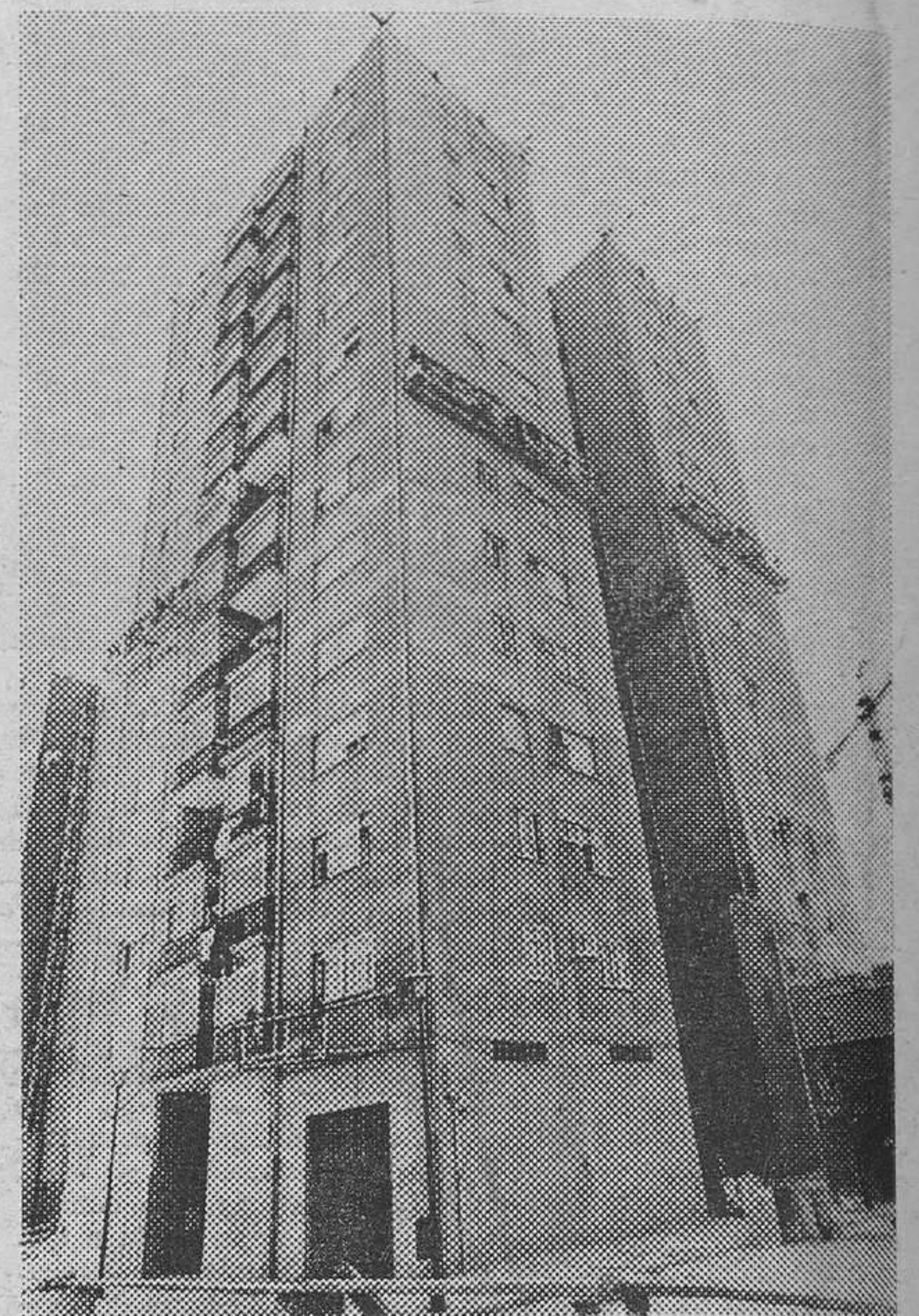
«Las Torres», un barrio en eterna construcción. Después de seis años, los andamios siguen colgados de las fachadas. — (Foto VILLAFRANCA).
