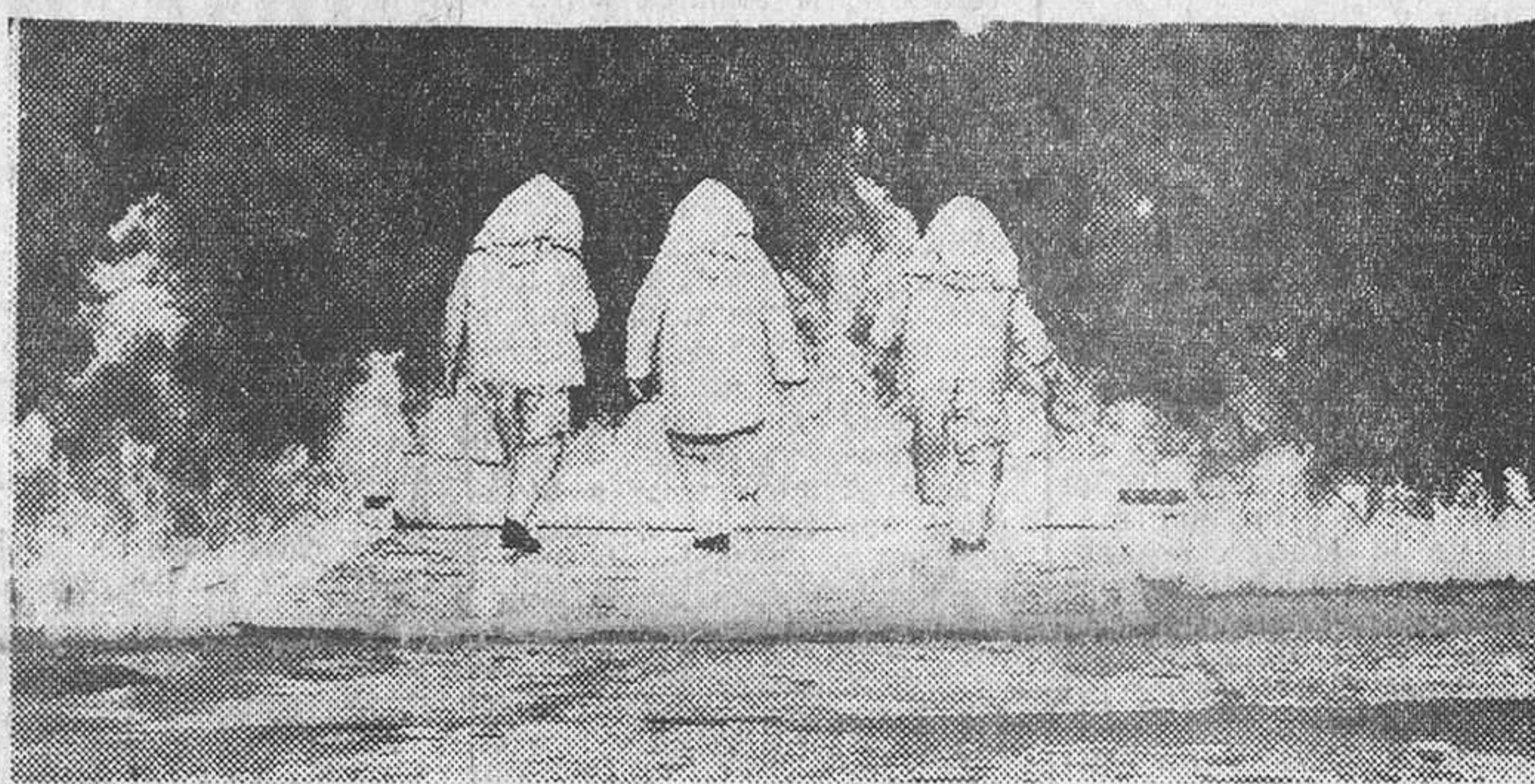
Stuttgart (Dad). — El paso a través del fuego se podrá efectuar de modo seguro sobre esta alfombra. En el aeropuerto de Stuttgart (República Federal de Alemania) fue presentada por primera vez esta alfombra incombustible. Precisamente en casos de accidente de aviones se suelen producir rápidamente incendios de gran extensión superficial por el derrame del combustible. En tales casos resulta generalmente difícil llevar con toda seguridad al edificio del aeropuerto o a las ambulancias los pasajeros que abandonen el avión a través de las alas o de los desahucios de emergencia. Mediante esta alfombra incombustible (nuestra foto) es posible por decirlo así, alargar el desahucio. El utensilio salvavidas, para el cual se ha solicitado el tratamiento la patente, se compone de varias capas de aluminio, de un tejido impregnado de productos químicos especiales y de un recubrimiento de plástico. Es de suponer que, además del aeropuerto de Stuttgart, se interese otros aeropuertos de la República Federal de Alemania y del extranjero por esta alfombra salvadora.
