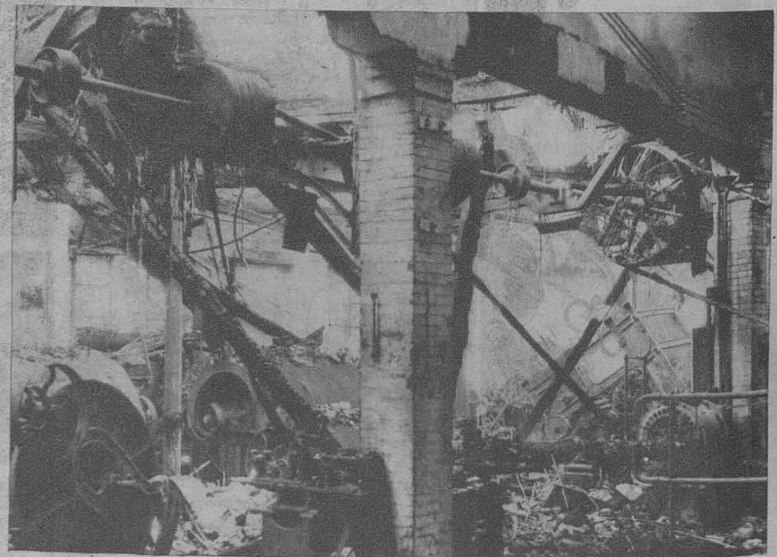
Un detalle del estado en que quedó una de las fábricas más importantes de mantas de Valencia, después del incendio que la destruyó casi totalmente. (Foto Alonso)
