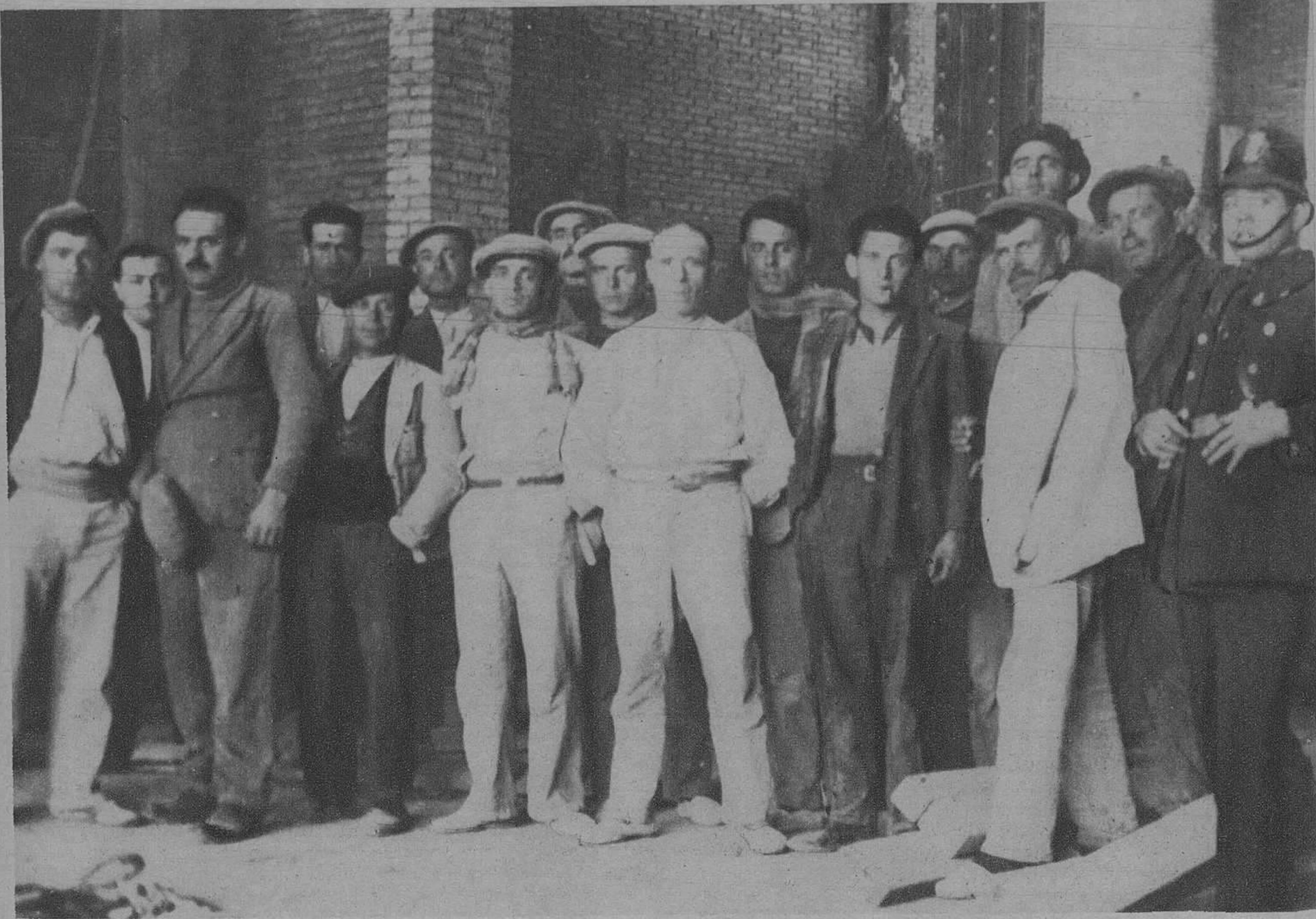
Del accidente ocurrido ayer en la finca que el Sr. March está construyendo en la plaza de Emilio Castelar. Grupo de obreros que trabajaban en el andamio que se desprendió, cayendo varios de sus compañeros del quinto piso al sótano, quedando gravemente heridos.
