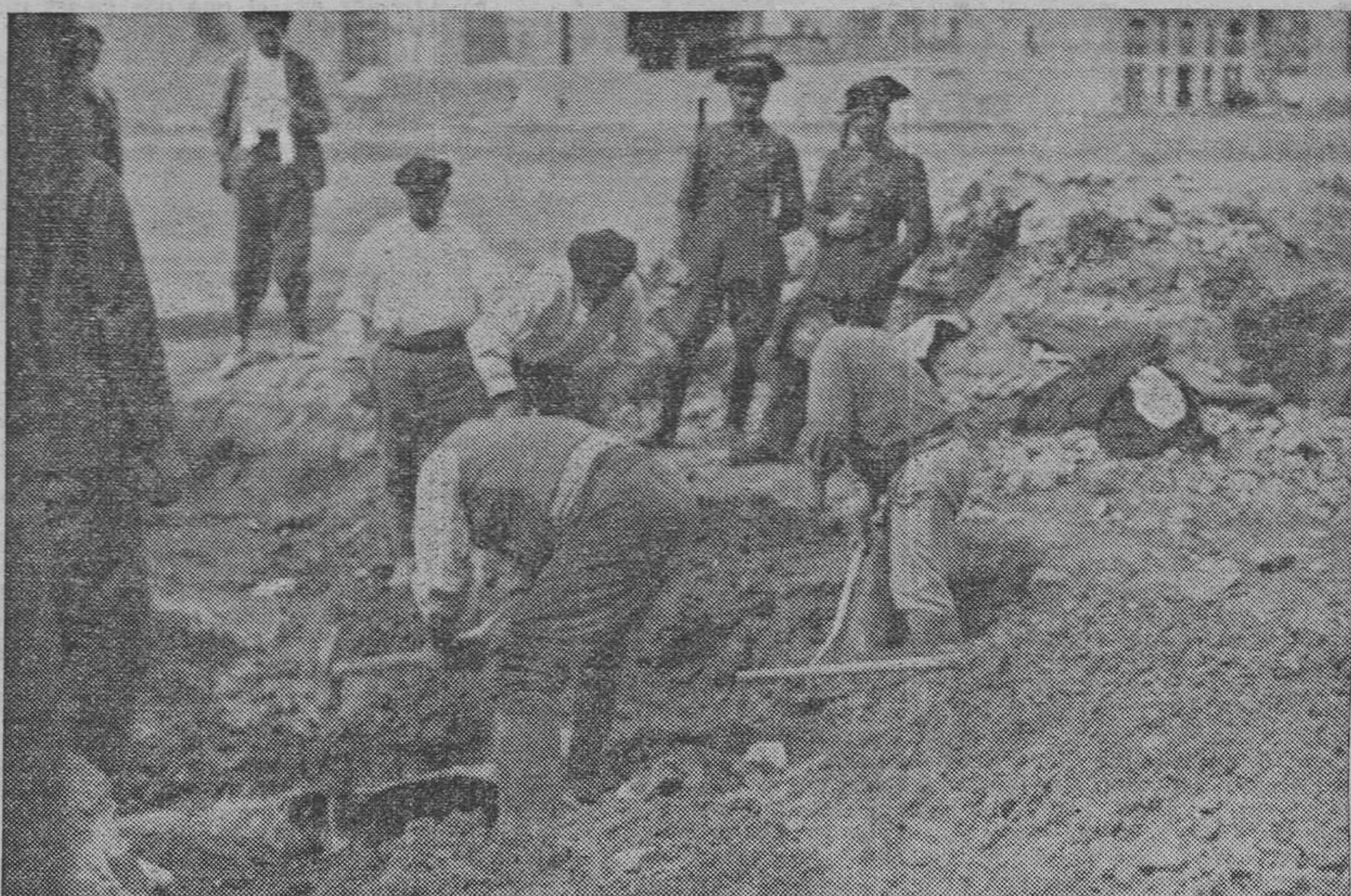
Reparando las averías causadas por una bomba en la calle de Jacinto Benavente, en las cañerías del agua (Fot. Barberá Masip.)
